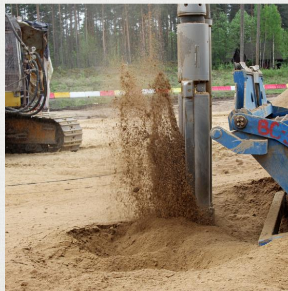
Усиление грунтов основания
