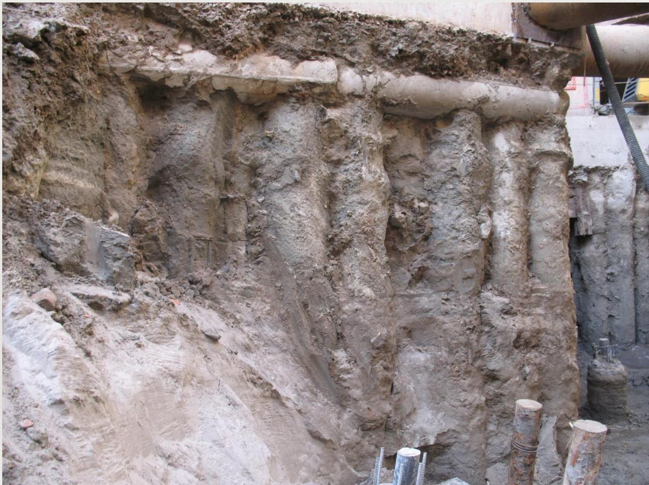
Буроинъекционные микросваи сами по себе могут применяться в качестве удерживающего сооружения в виде стены из бурокасательных свай.
