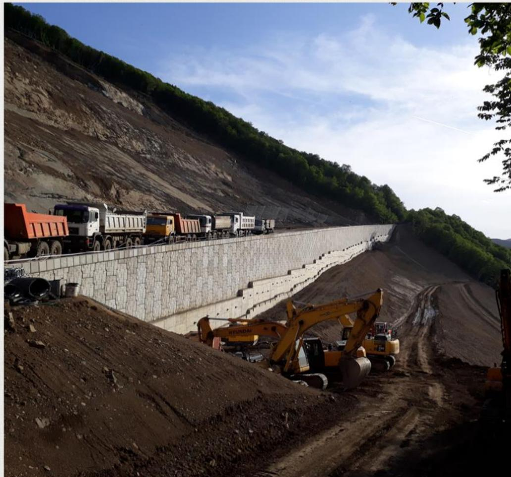
Два участка разрушенной автодороги восстановлены с устройством армогрунтовой системы.
