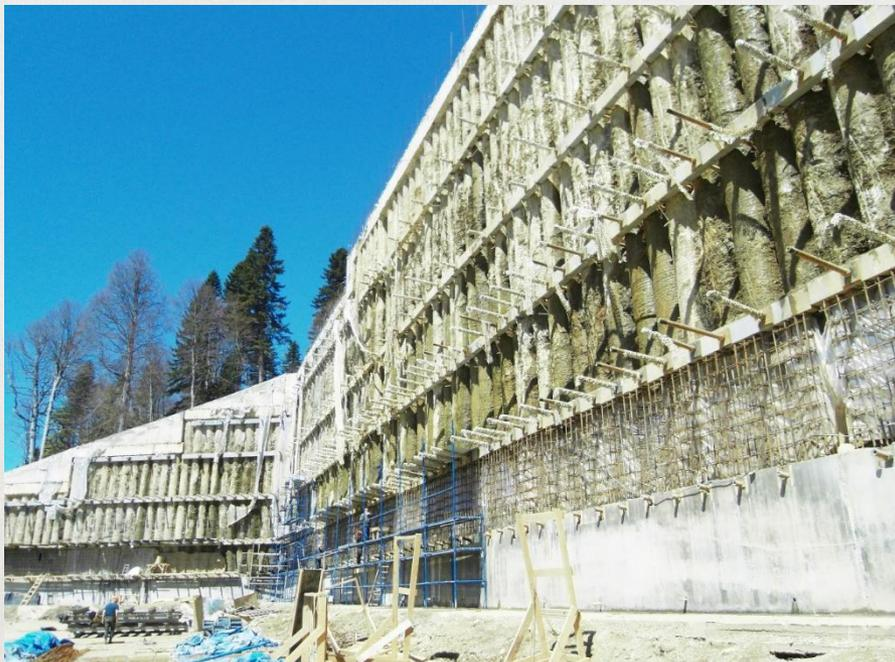
Обеспечение устойчивости свайной подпорной стены высотой 26 метров (из бурокасательных свай) через пять поясов анкерного крепления, выполненного через распределительные балки.
