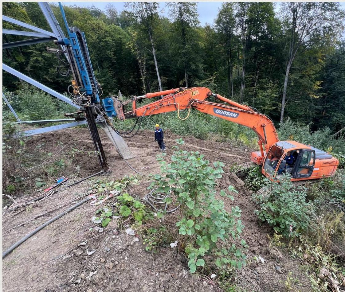
Для выполнения свай применен буровой анкерный лафет DM-140, закрепляемый на стреле экскаватора.
