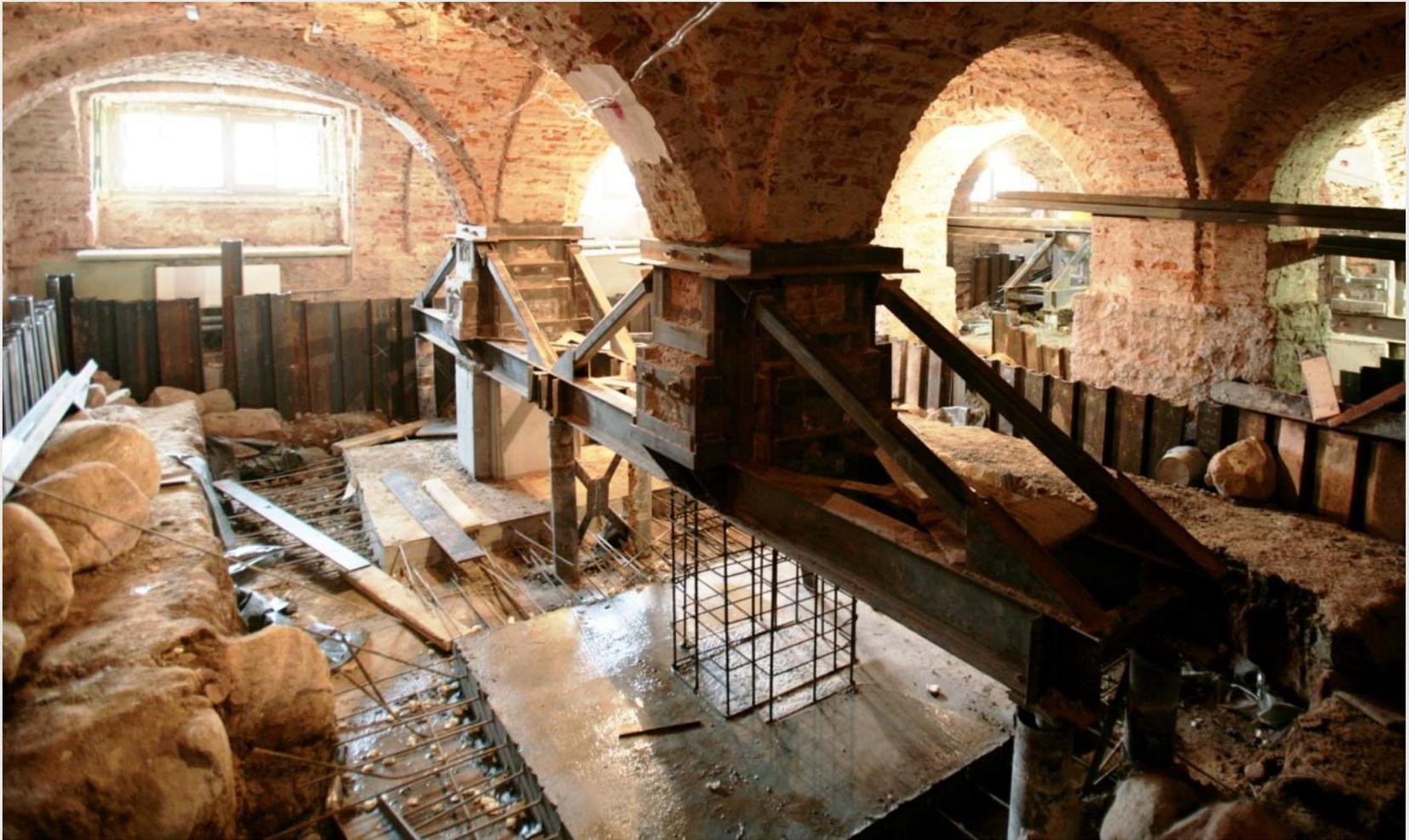
Нагрузки от всех колонн сводчатого перекрытия одновременно передали через обоймы на временные сваи, после чего разработали грунт и выполнили фундаментную плиту.
