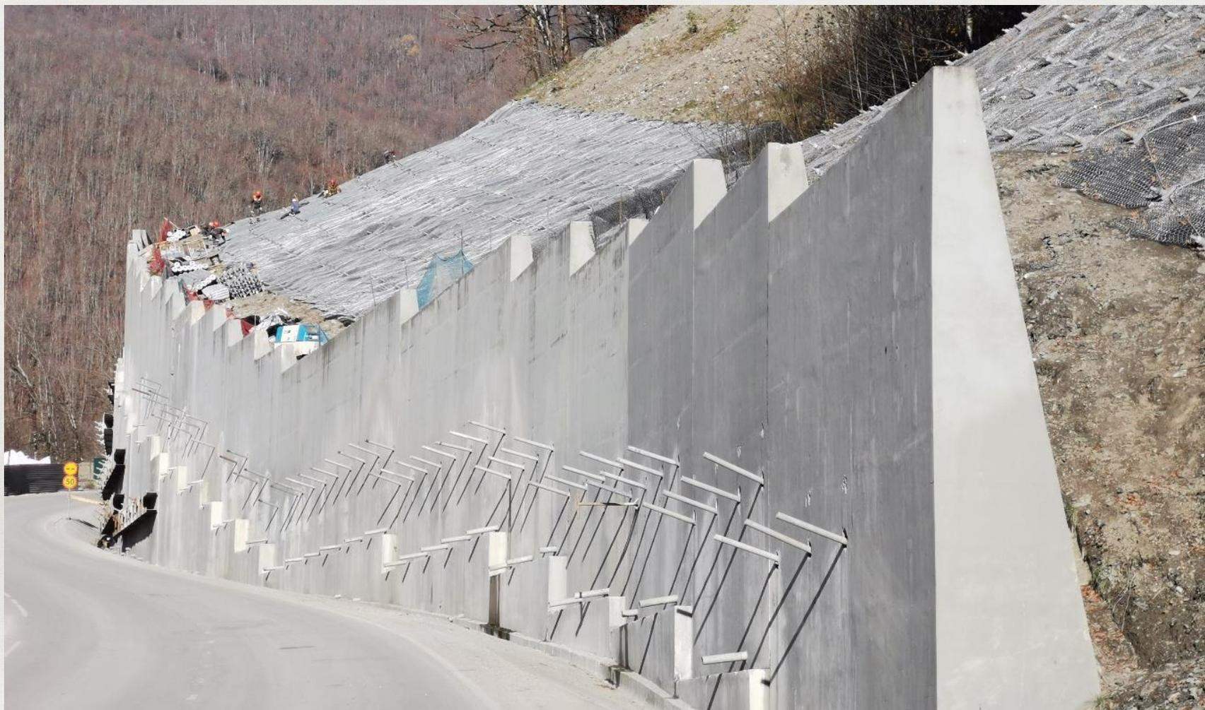
Усиление аварийных подпорных стен с устройством дополнительного анкерного крепления с использованием GEOIZOL-MP.
