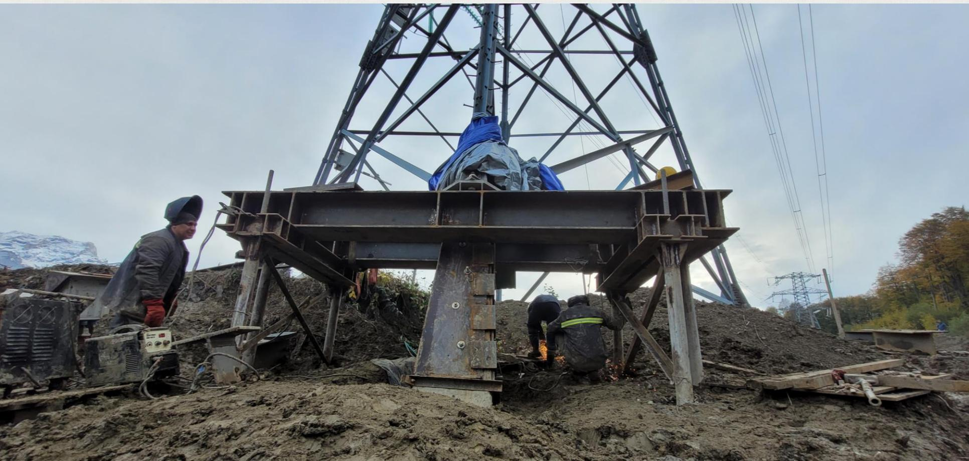
Передача нагрузки от опоры на новые фундаменты через металлическую обойму.
