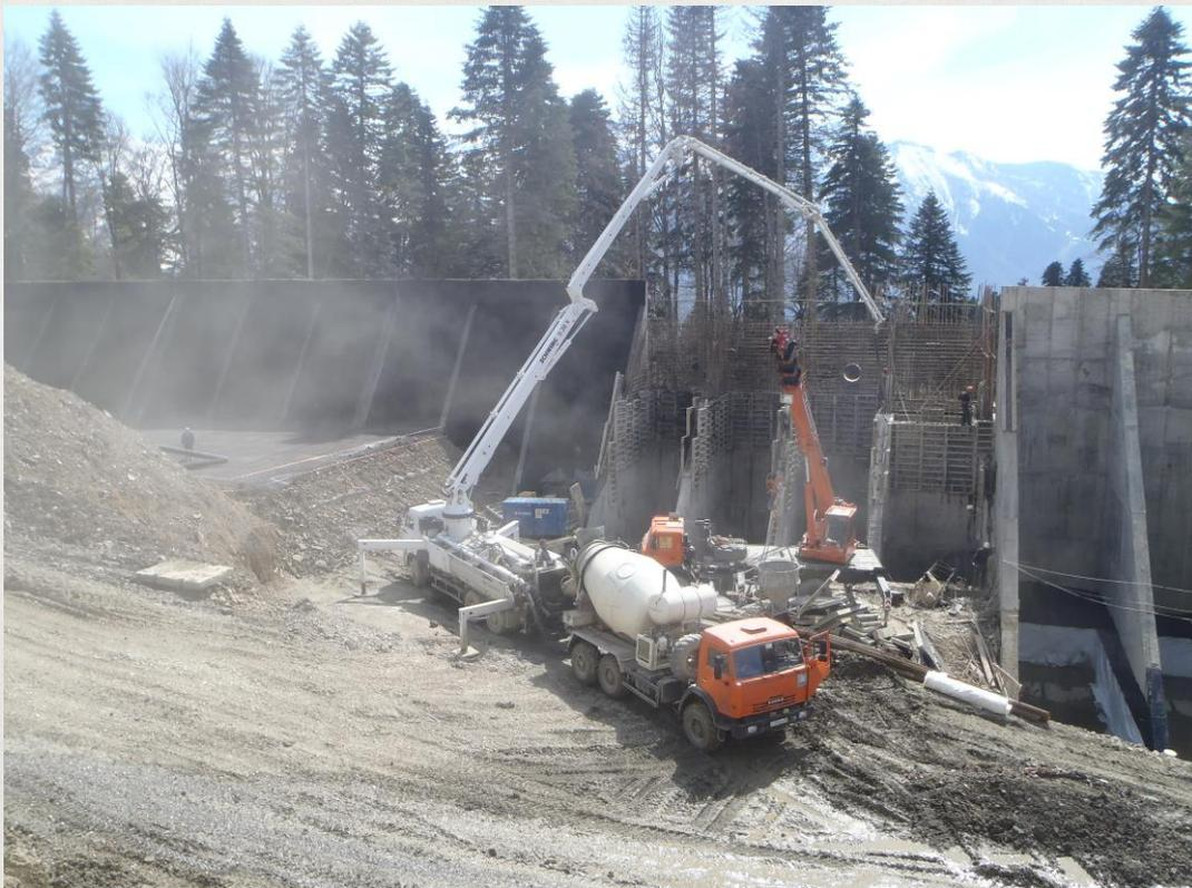
Строительство уголковой подпорной стены с контрфорсами на свайном основании.
