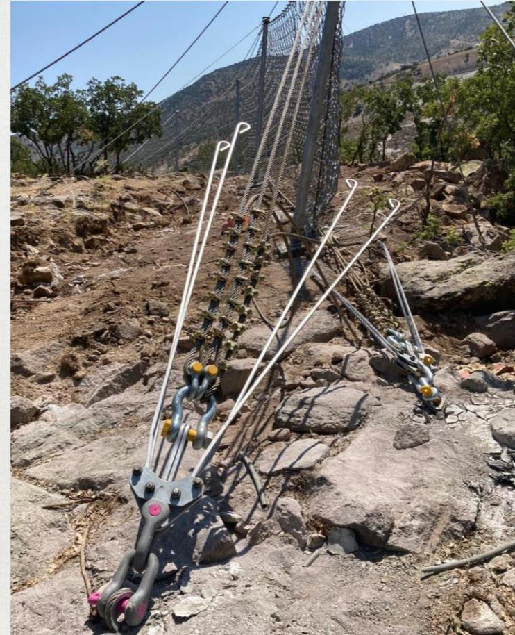
Анкеры GEOIZOL-MP применяются в качестве крепежного элемента конструкций, предназначенных для инженерной защиты от камнепадов, селей, лавин и т.п.
