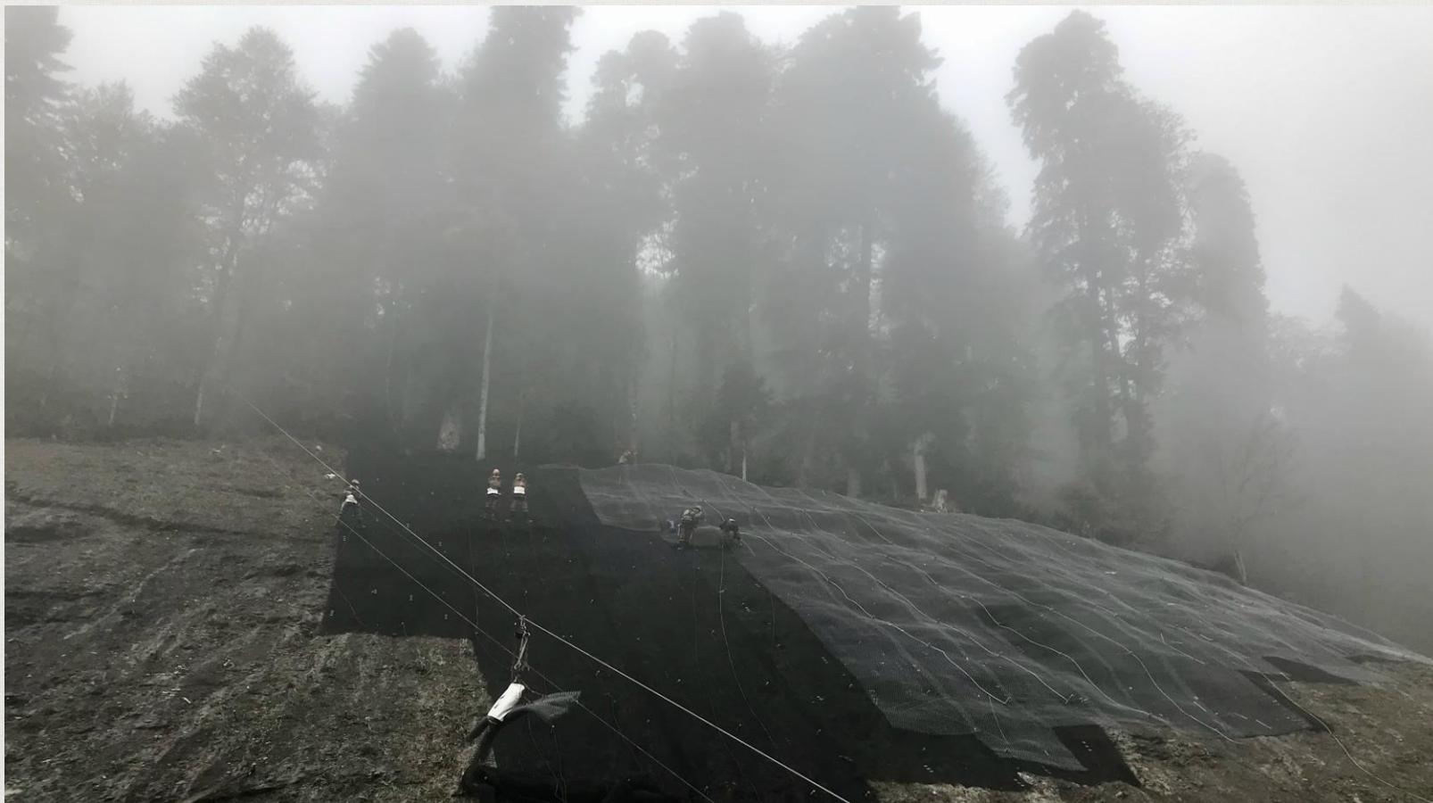
Покровная система (высокопрочная стальная сеть в комбинации с противоэрозионными матами) препятствует смещениям на поверхности склона и не допускает вывалов грунта в межнагельном пространстве.
