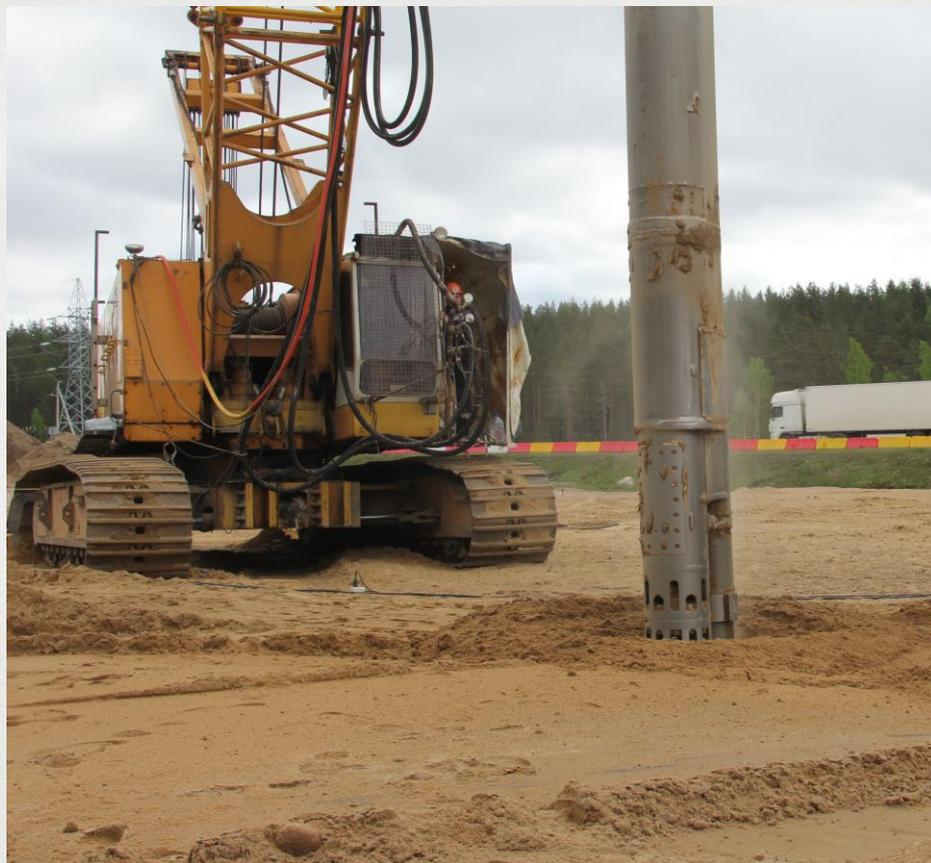
«**Щебеночные сваи**» – представляют собой технологию модификации грунтового массива путем формирования столбов из инертных материалов (щебня, строительного песка, песчано-гравийной смеси (ПГС), рецикла бетона и т.д.) методом виброуплотнения.
