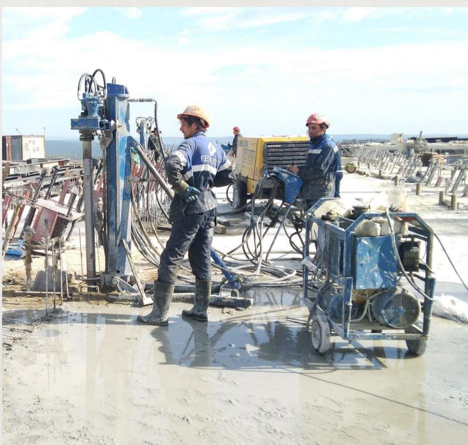
Сваи GEOIZOL-MP 103/78 длиной 3,5 – 5,5 м выполнены без лидерного бурения в гранитное основание.
