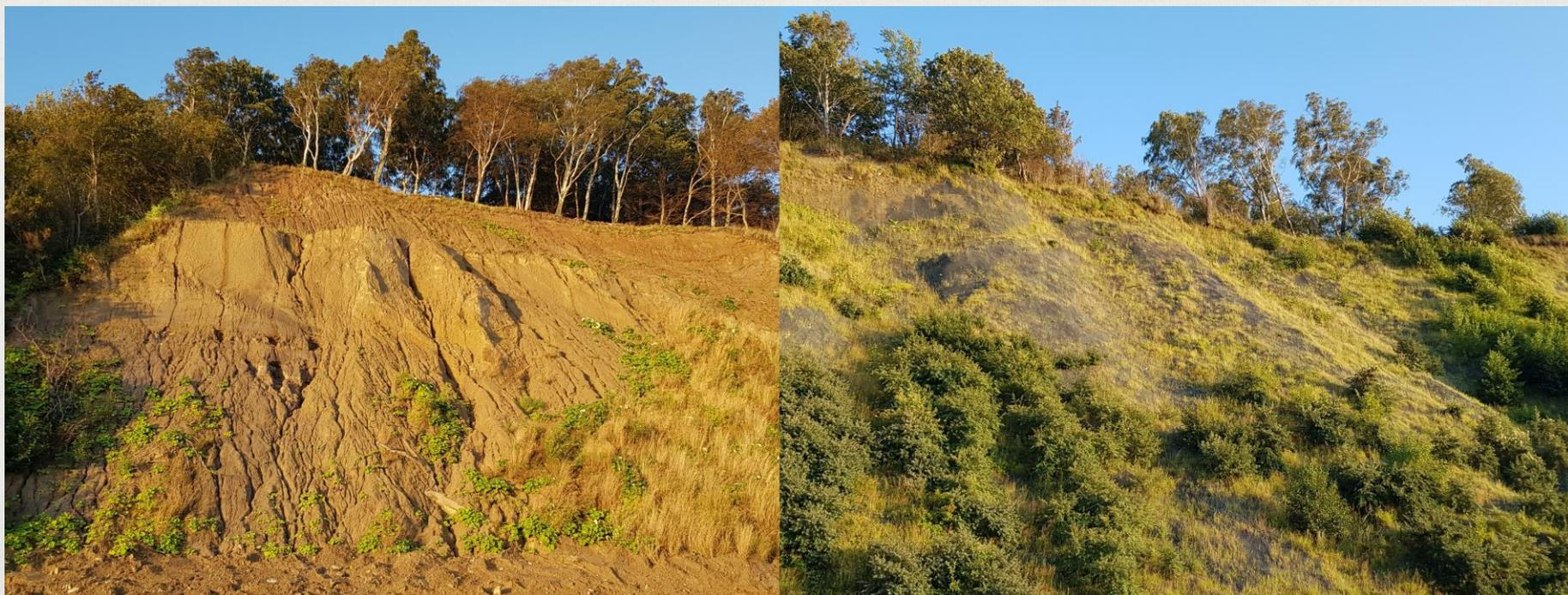
Участок склона до (слева) и после выполнения нагельного крепления и противозерозионной защиты (справа)
