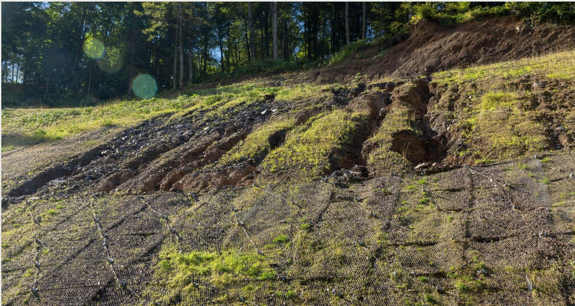
**Эрозия** – совокупность процессов разрушения верхнего слоя грунта (почвы).
