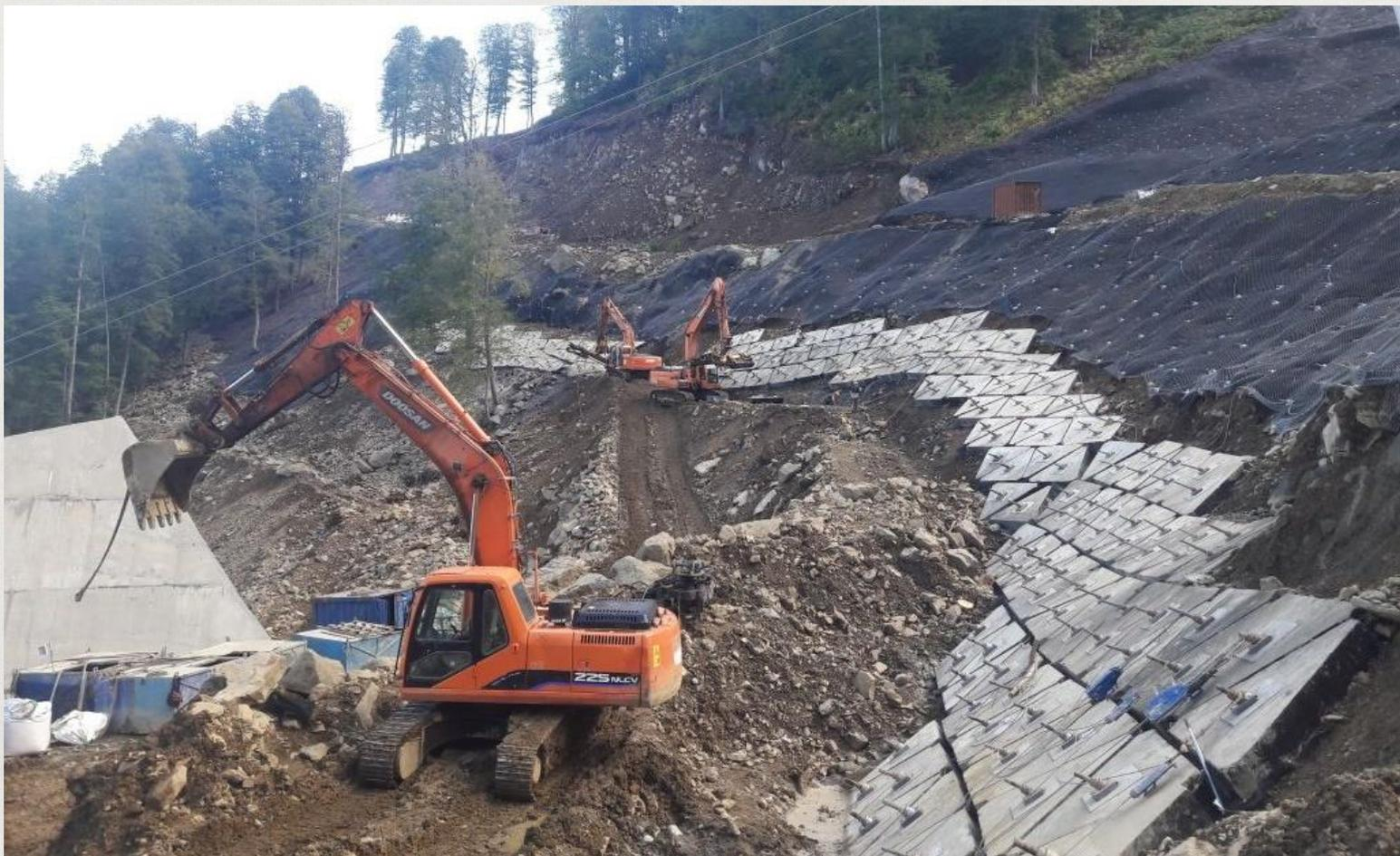
**Анкерное крепление с прижимными плитами** – компактный аналог пригрузочной бермы.
