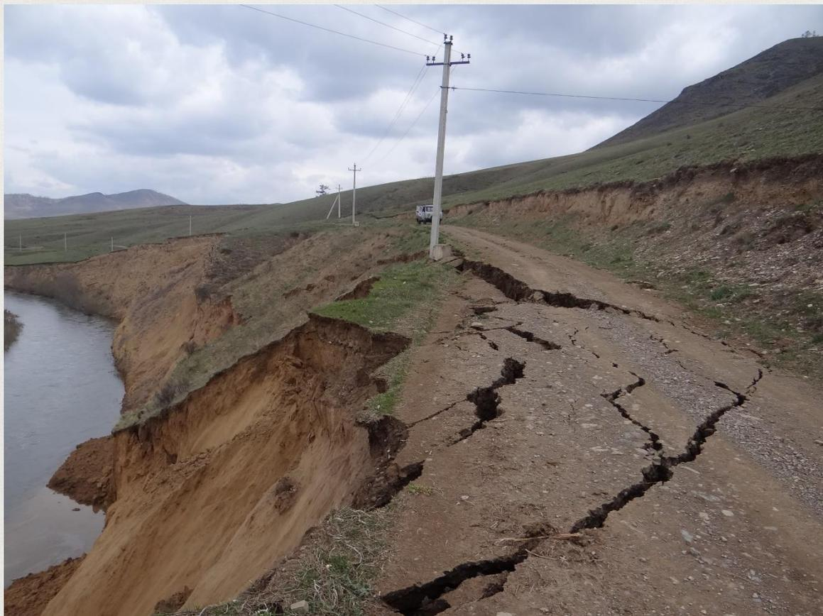
В пределах активных оползней, как правило, необходимы **экстренные контраварийные работы**, для предотвращения воздействия оползневых масс на защищаемых объект, либо удержания части склона с самим защищаемым объектом (например, участком дороги).
