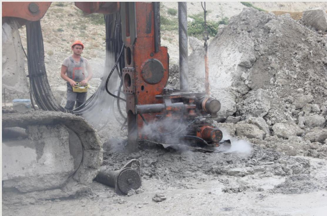
Замыв выполняется по технологии аналогичной струйной цементации (Jet Grouting) с меньшим рабочим давлением. Возможны варианты с устройством цементационной скважины или цементирования под защитой глинистого раствора. В грунтах со скальными включениями возможно выполнение цементации через лидерную скважину.
