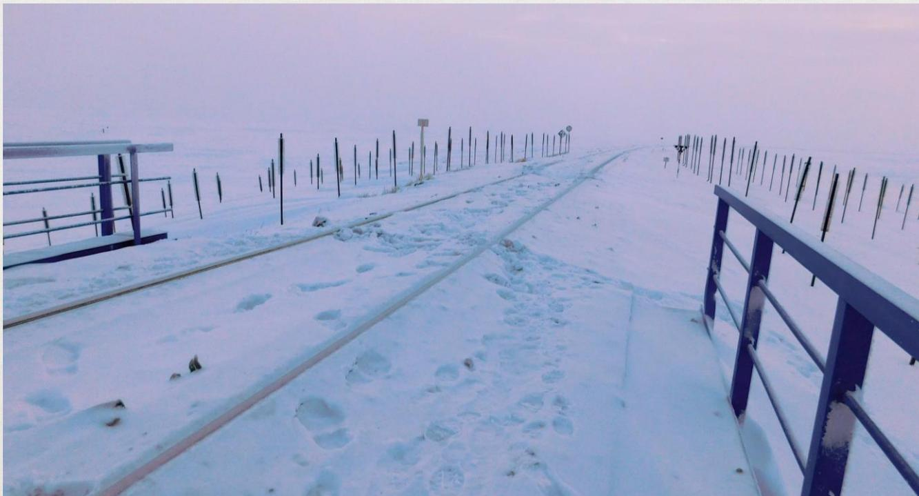
Элемент системы термостабилизации для защиты моста на участке железной дороги Обская - Бованенково
