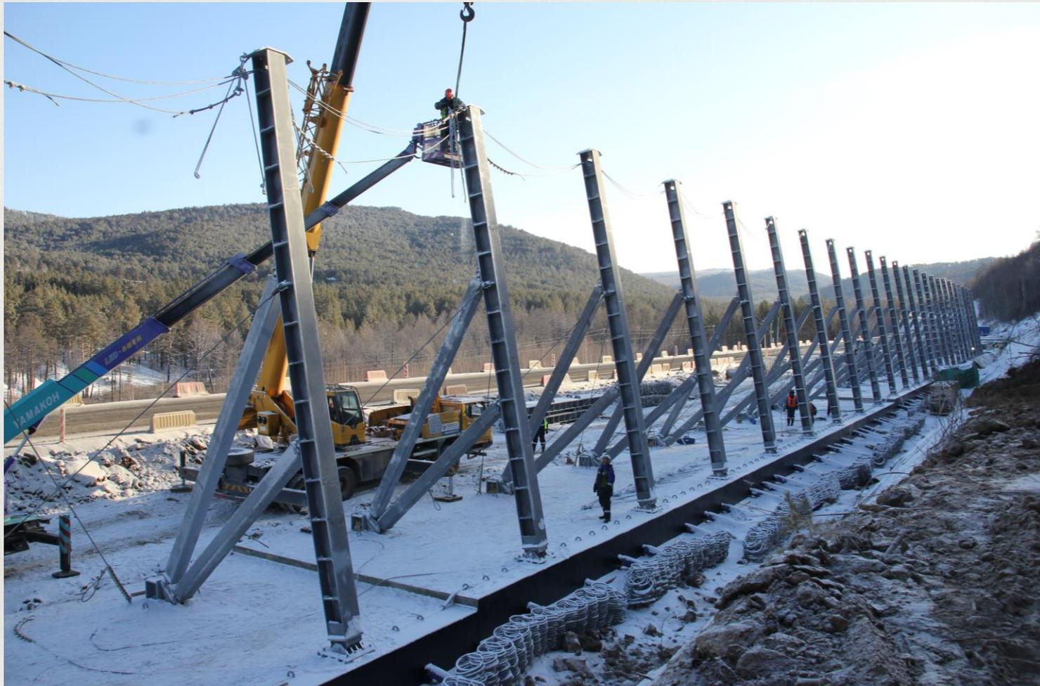
Селеудерживающий барьер сформирован лямбда-образными стойками на монолитном железобетонном свайном фундаменте.
