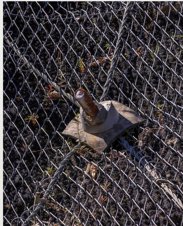
Нагели армируют массив, а покровная система (стальная сеть) препятствует вывалу грунта.
