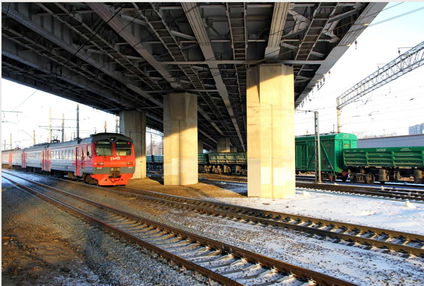
Фундаменты опоры №12 путепровода в створе Пискаревского проспекта в районе железнодорожной станции Ручьи, Санкт-Петербург.
