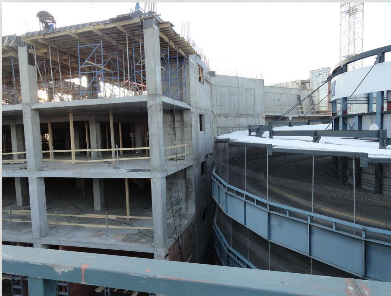
Свайное основание под рампу, ведущую в надземный паркинг (на крыше торгового комплекса). Ладожский вокзал, Санкт-Петербург.
