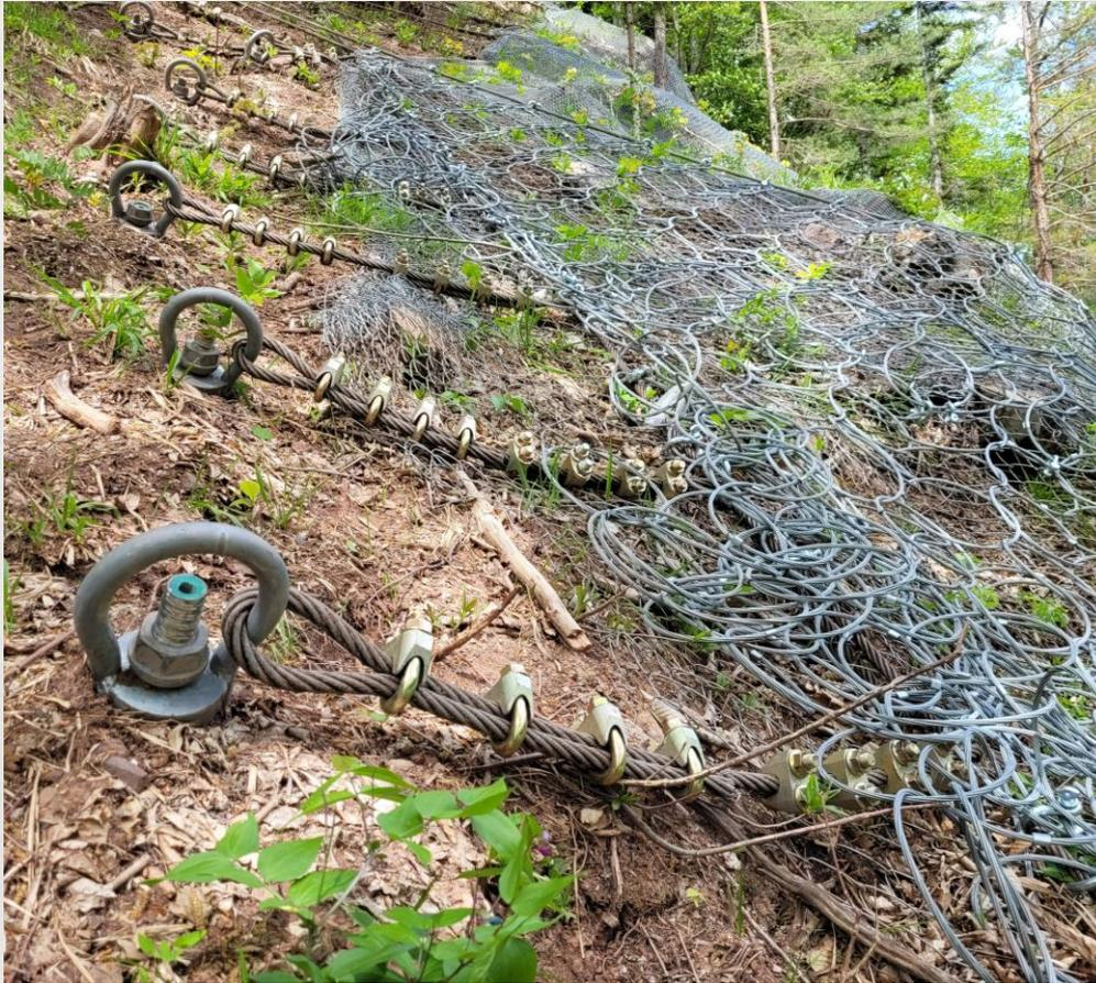
Анкеры GEOIZOL-MP применяются в качестве крепежного элемента конструкций, предназначенных для инженерной защиты от камнепадов, селей, снежных лавин и т.п.
