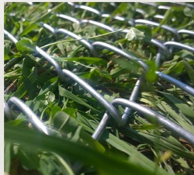
Покровная система – высокопрочная стальная сеть в комбинации с противоэрозионными матами.
