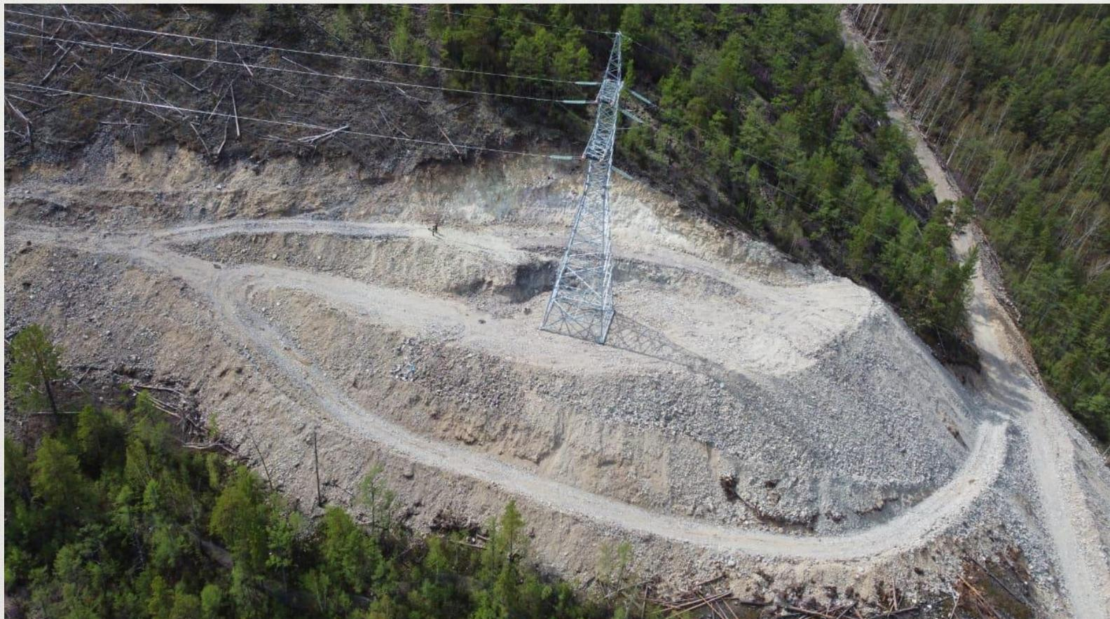
Для ускорения ввода в эксплуатацию ВЛ 220 кВ Зилово - Могоча даны рекомендации по устройству насыпи. Работы по инженерной защите (на особое сочетание нагрузок) выведены на второй этап.
