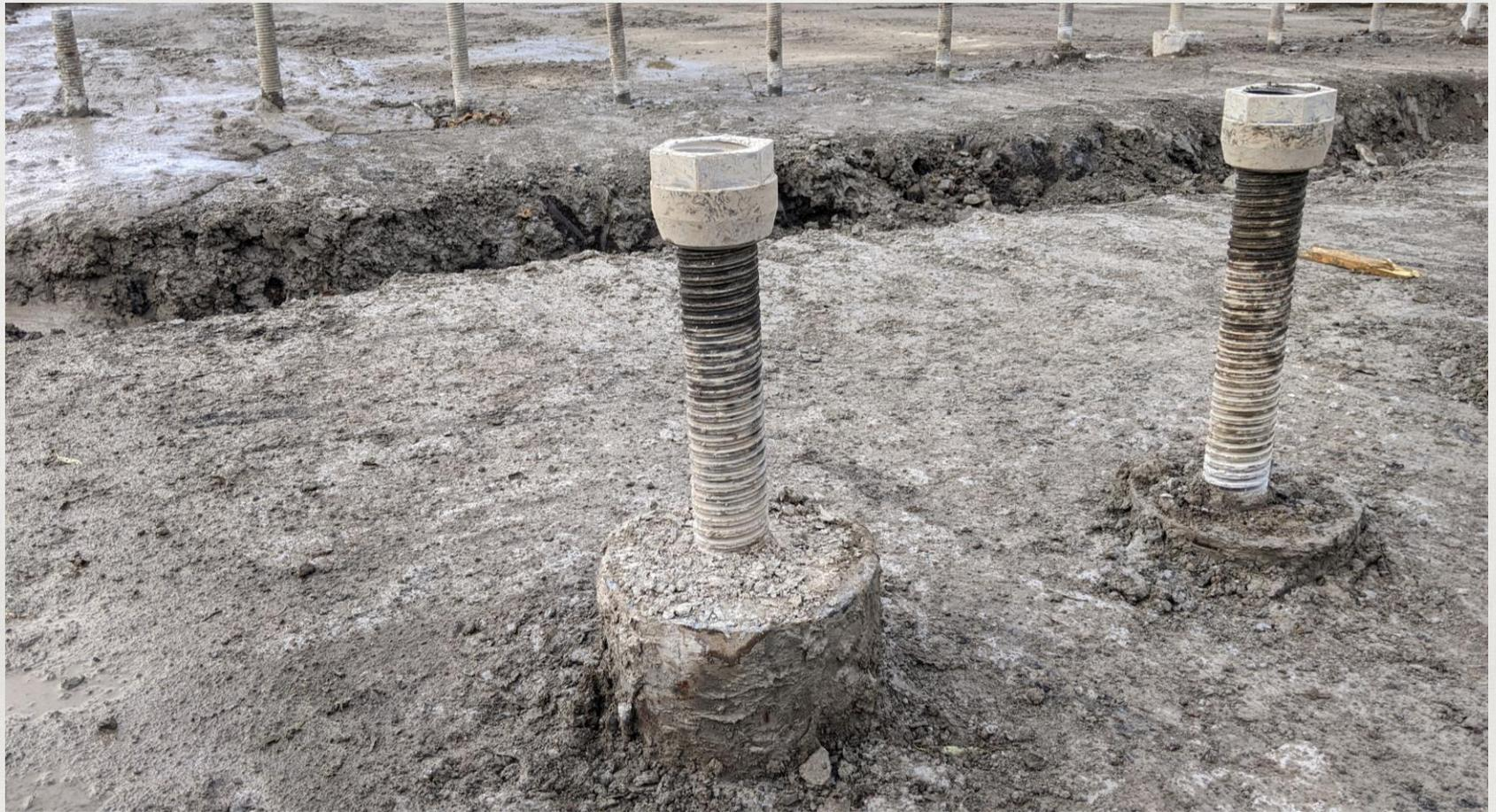
В верхней части сваи усилены стальными трубами. Дополнительное армирование позволяет компенсировать изгибающие моменты и применять сваи меньших диаметров.
