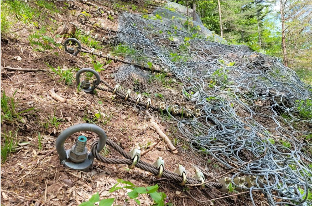
Несущий канат закрепляется на рельефе с помощью грунтовых анкеров GEOIZOL-MP. Анкерную группу, как правило, выполняют за пределами камнепадоопасной зоны. Связь между канатом и анкерами обеспечивается с помощью канатных оттяжек.
