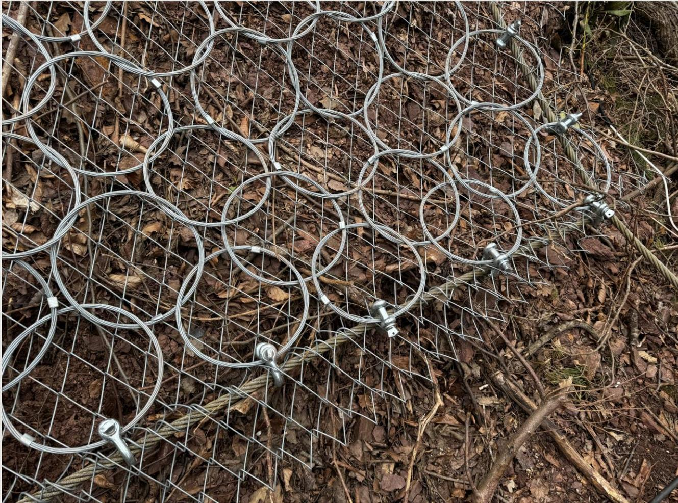
По низу сетки прокладывают натяжной канат для удержания каменного материала. После ослабления каната порода расчищается механически.
