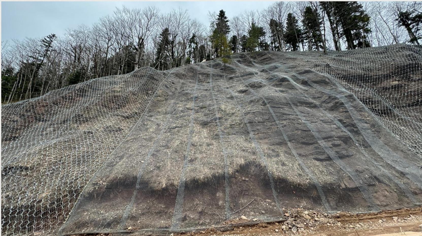
На одном опасном участке применена высокопрочная сеть 2Д-GeoW56/4 ПРО.
