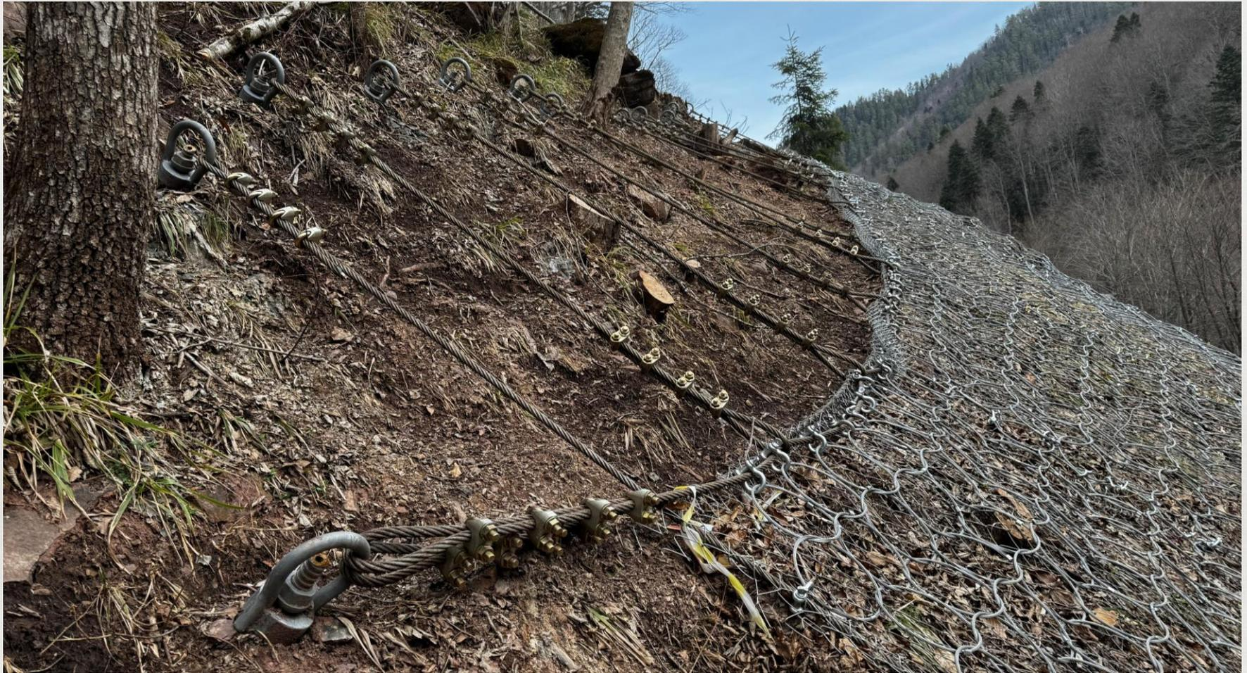
Как правило, конструкция крепится лишь к несущему канату, пущенному по верхнему краю сетчатого полотна.
