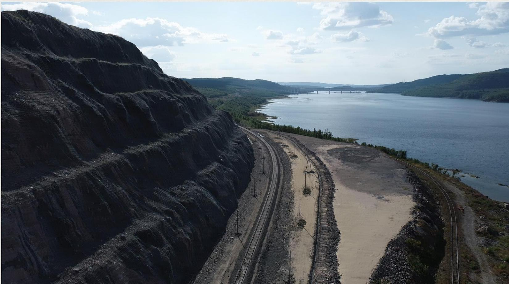
Для обеспечения транспортной доступности порта «Лавна» протянута новая линия железной дороги. Для ее прокладки потребовалось изменить рельеф – подрезать часть горного уступа.
