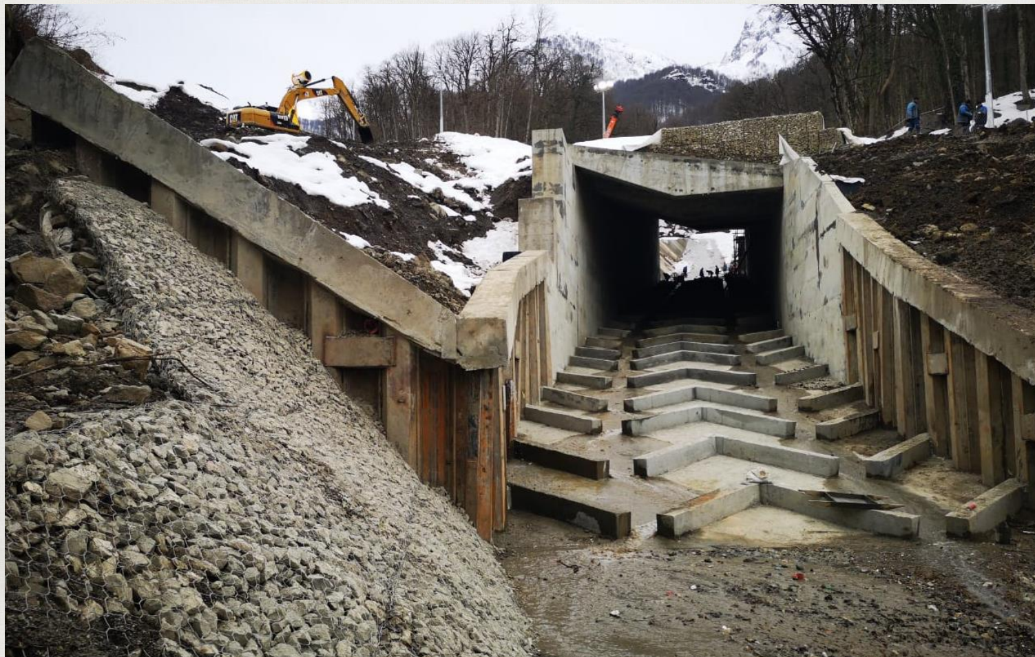
Селепроект закрытого типа, построенный в русле ручья Ржаной предназначен для защиты лыжных трасс.
