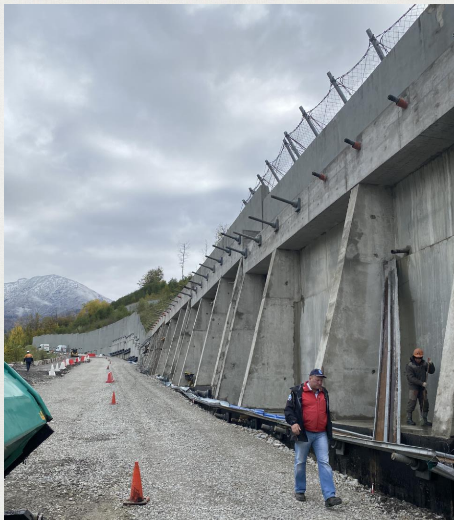
Выполнение монолитных работ.
