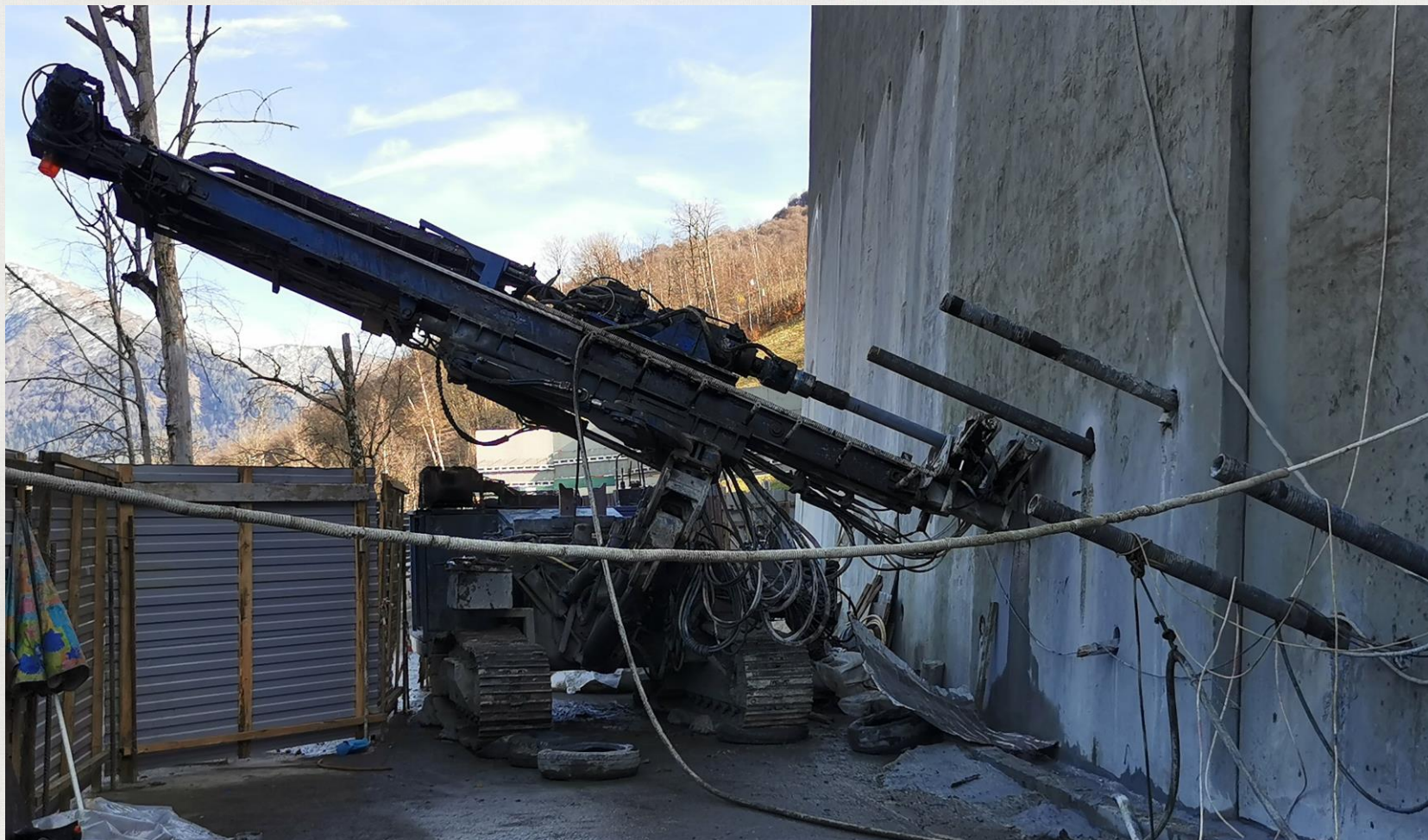
Усиление существующих подпорных стен грунтовыми анкерами.
