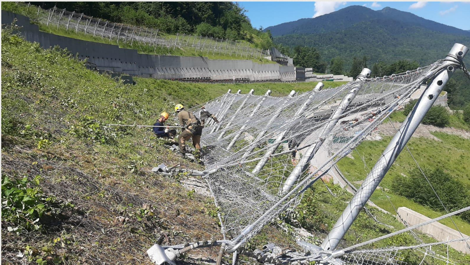
Монтаж снегоудерживающих барьеров.
