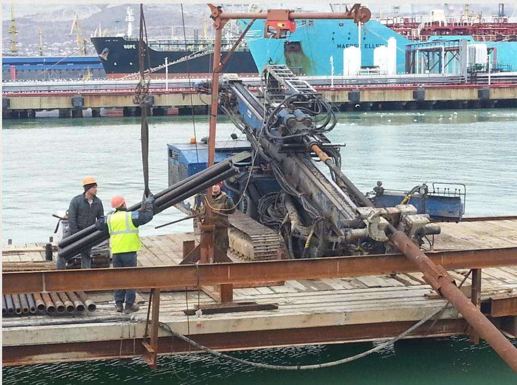
Устройство анкерного крепления в теле пирса с использованием надводного понтона и металлического кондуктора длиной 21 метр.
