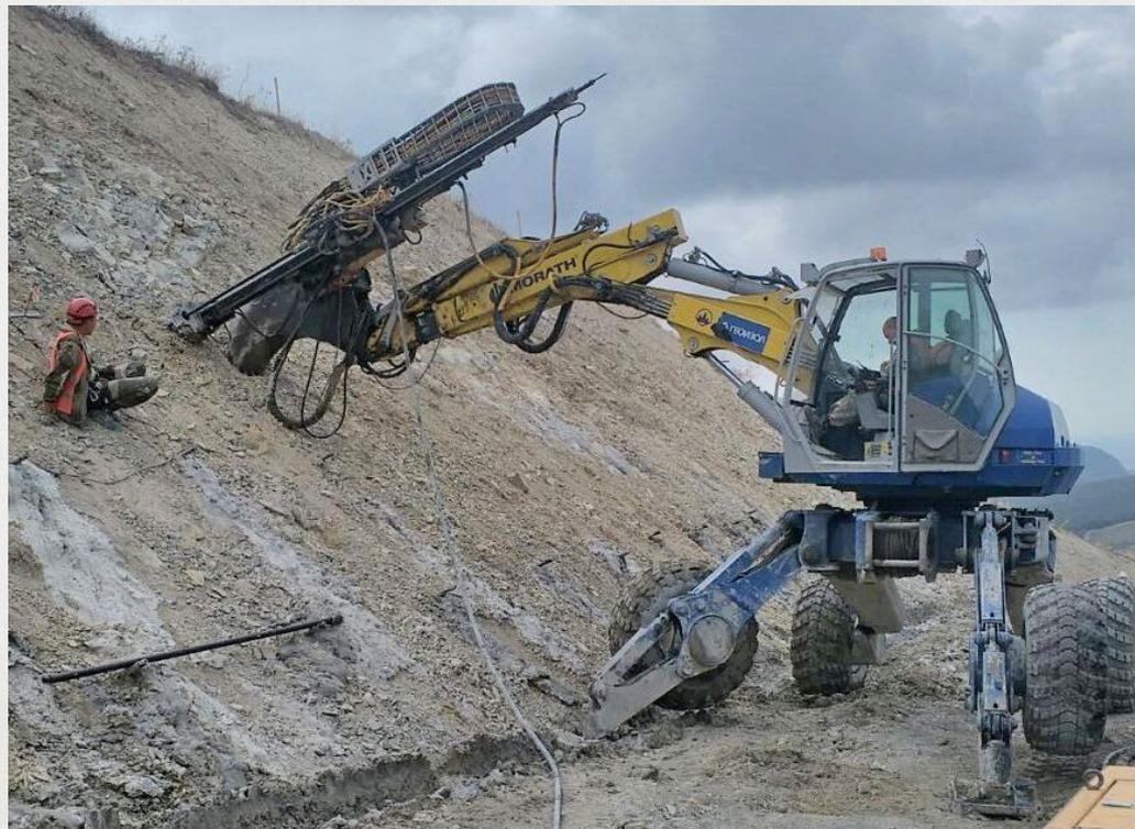
Для устройства МГТС применяется широкий спектр буровой техники, включая навесное оборудование (устанавливаются на экскаваторы) и малогабаритные (в том числе горные) установки.
