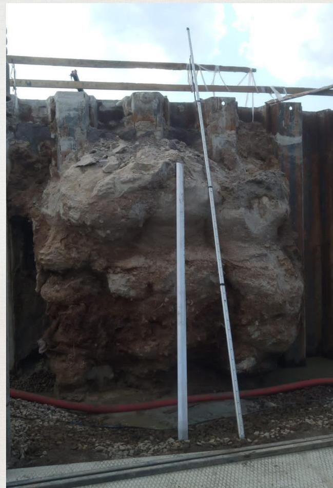
Для обеспечения герметичности шпунтового ограждения с обратной стороны (по швам) выполняются грунтоцементные элементы методом струйной цементации (Jet Grouting).
