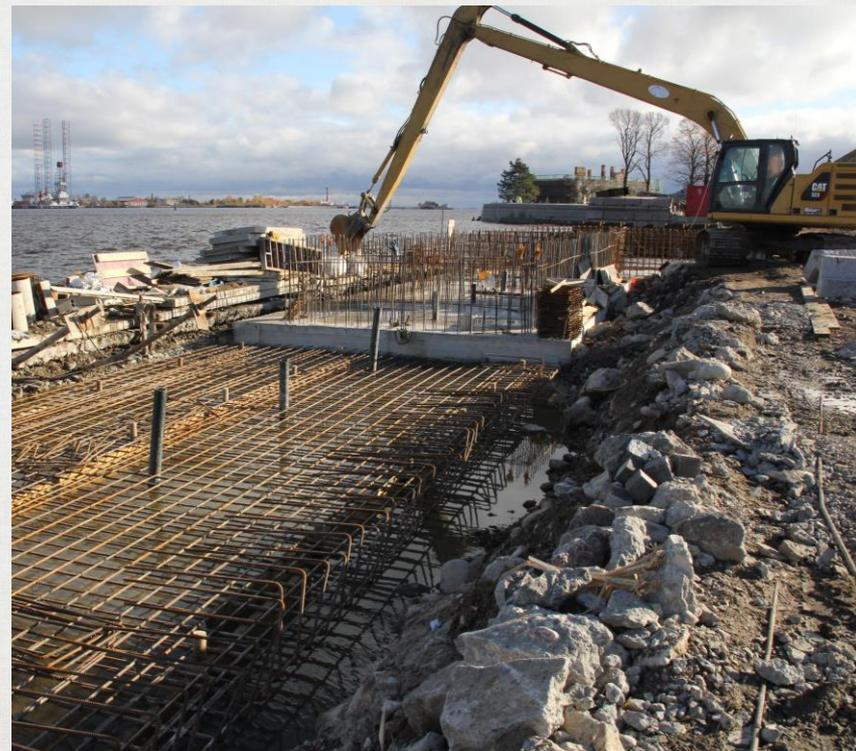
Устройство основания из буронагнетательных свай GEOIZOL-MP под железобетонный ростверк. Форт «Кроншлот», Кронштадт.
