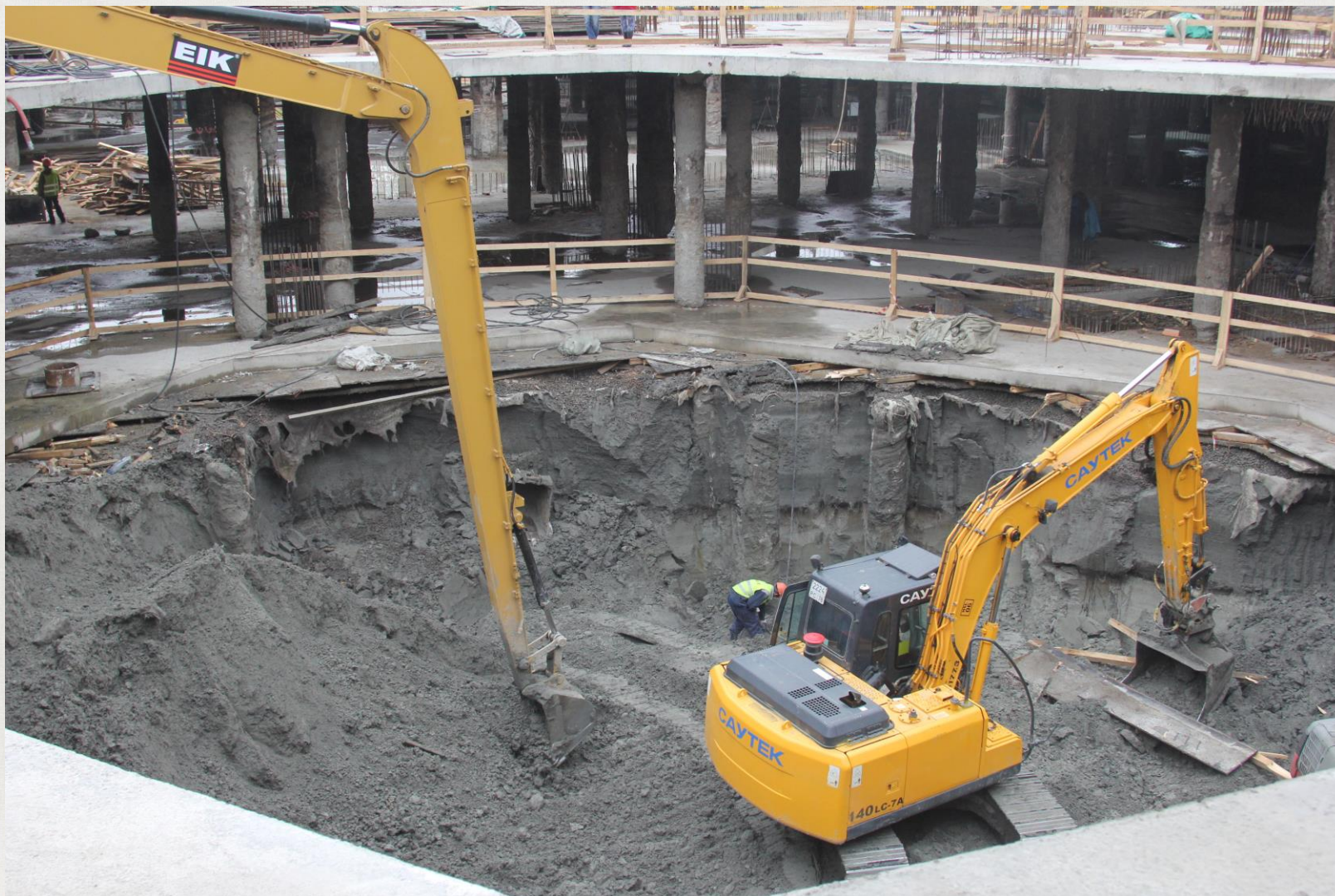
Разработка грунта на минус втором ярусе.
