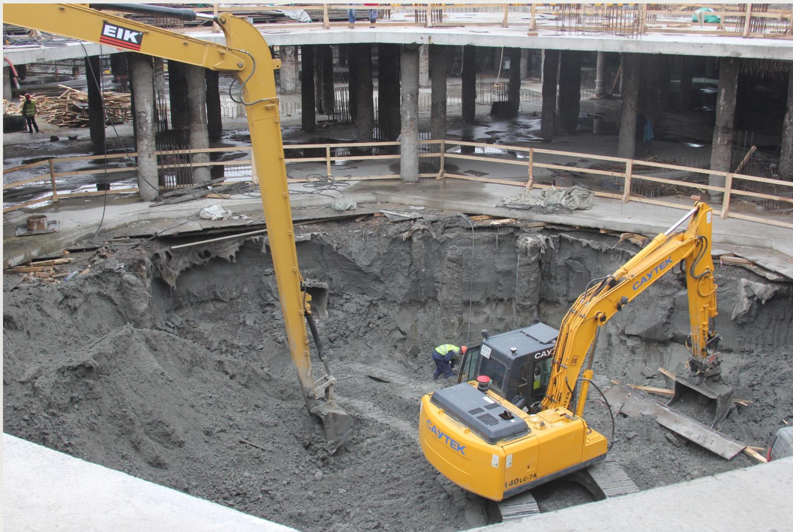
Разработка грунта на минус втором ярусе.
