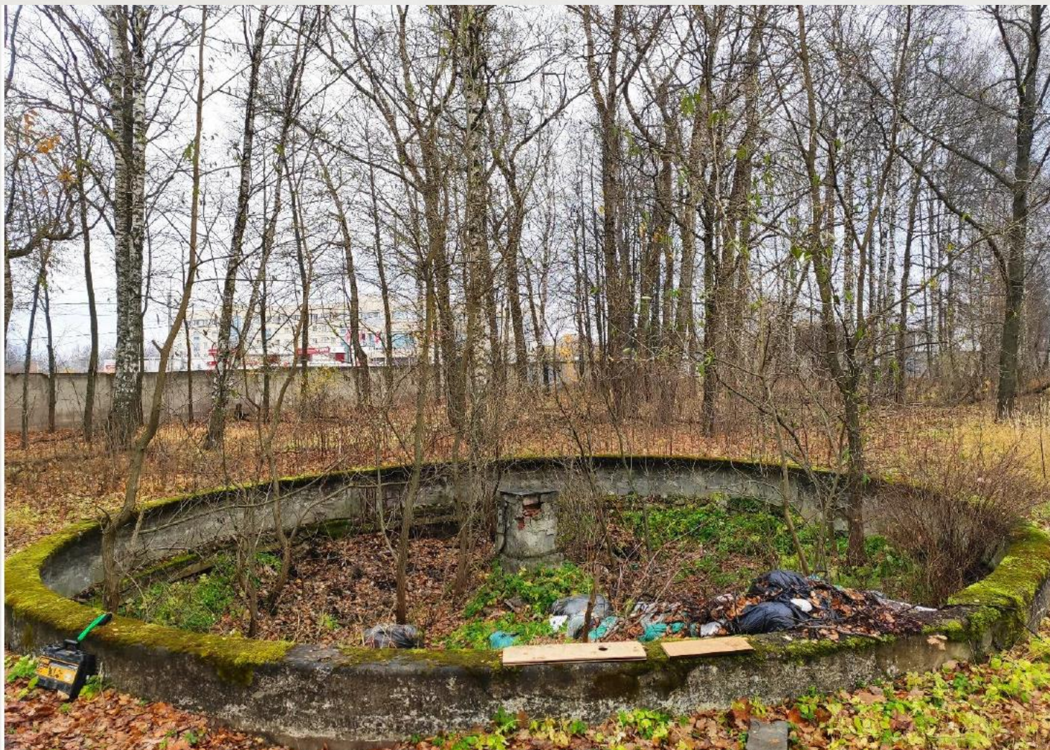
Состояние фонтана до начала выполнения работ.
