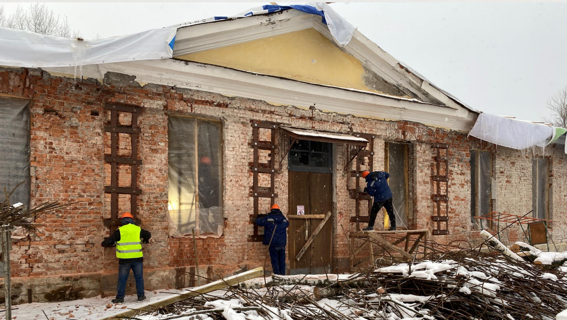
Усиление стен металлическими обоймами здания хирургии (ГП 3).
