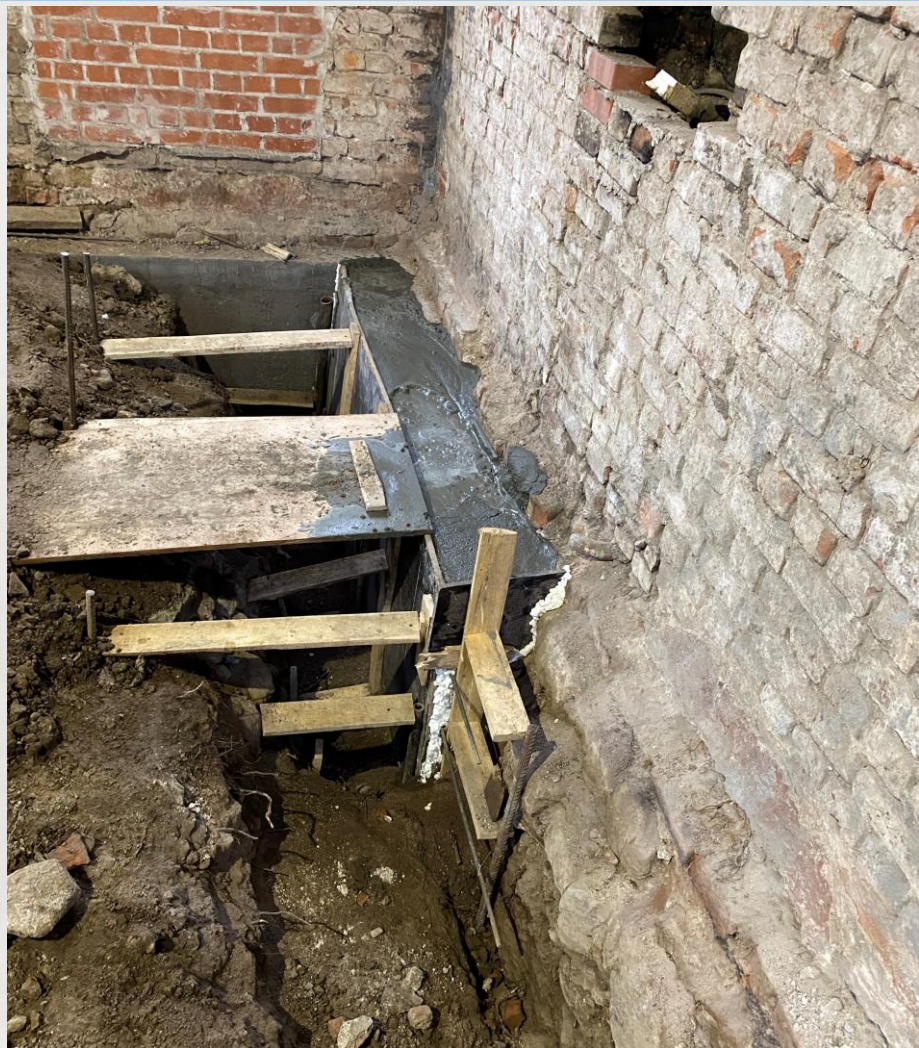
Устройство обойм фундаментов.
