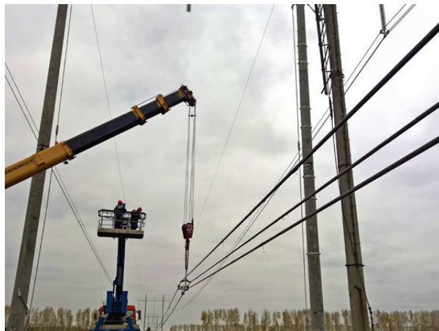
Рис. 4. Демонтаж подвески средней фазы проводов
