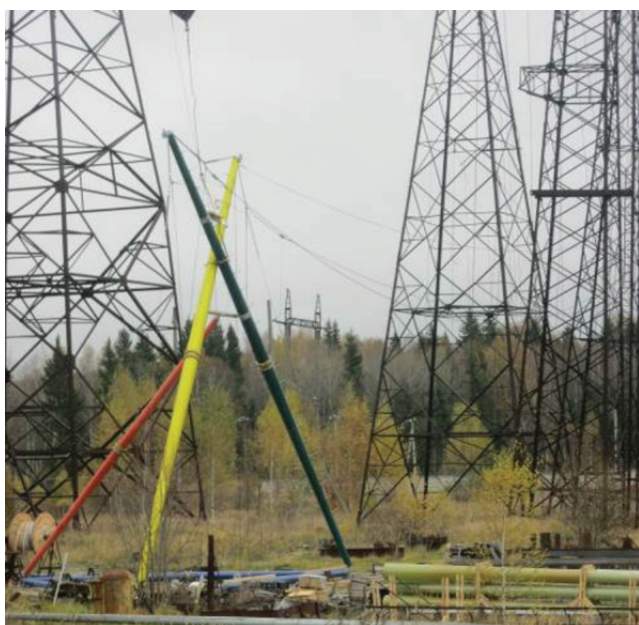
Рис. 3. Испытание быстромонтируемой одноцепной облегченной опоры БК110-1 ВЛ 35-110 кВ из композитных материалов.
