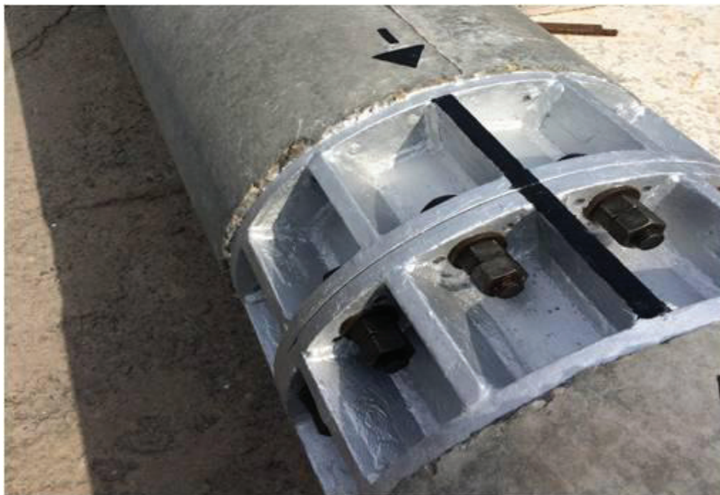
Рис. 1. Внутренний фланец для соединения секций
