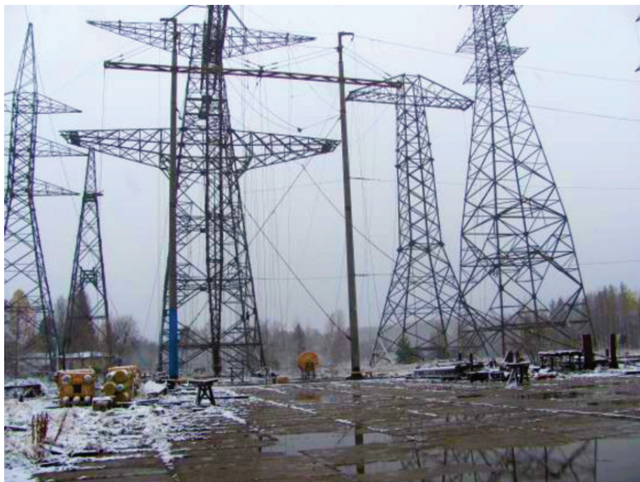
Рис. 13. Испытание железобетонной промежуточной опоры 2СП500-3В из секционированных стоек
