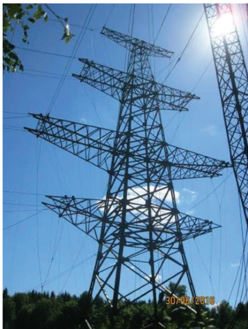
Рис. 10. Испытание двухцепных анкерной угловой стальной решетчатой опоры типа УС500-2/14 и промежуточной стальной решетчатой опоры типа ПС500-2/28,5
