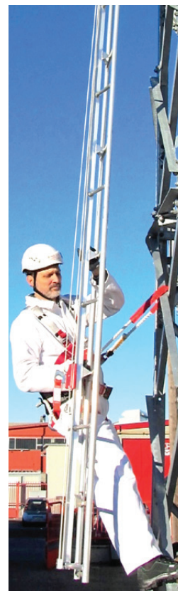
Рис. 23. Установка штурмовой лестницы на опоре.
