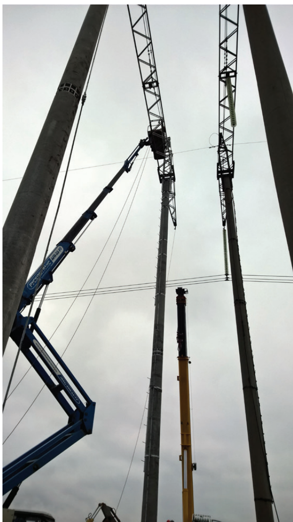
Рис. 3. Установка автокрана и автогидроподъемника для монтажно-демонтажных работ по опорам, гирляндам изоляторов, проводам и грозотросу
