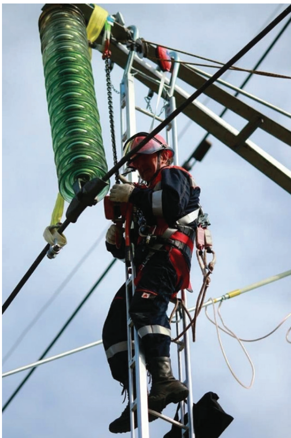
Рис. 29. Международные соревнования электромонтеров в г. Бресте. Подвесная лестница для работы на изоляторах.
