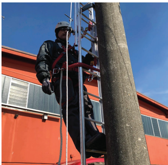
Рис. 19. Подъем по смонтированной опоре с ЖАЛ
