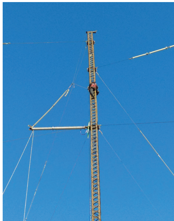
Рис. 4. Монтаж изолирующих траверс
