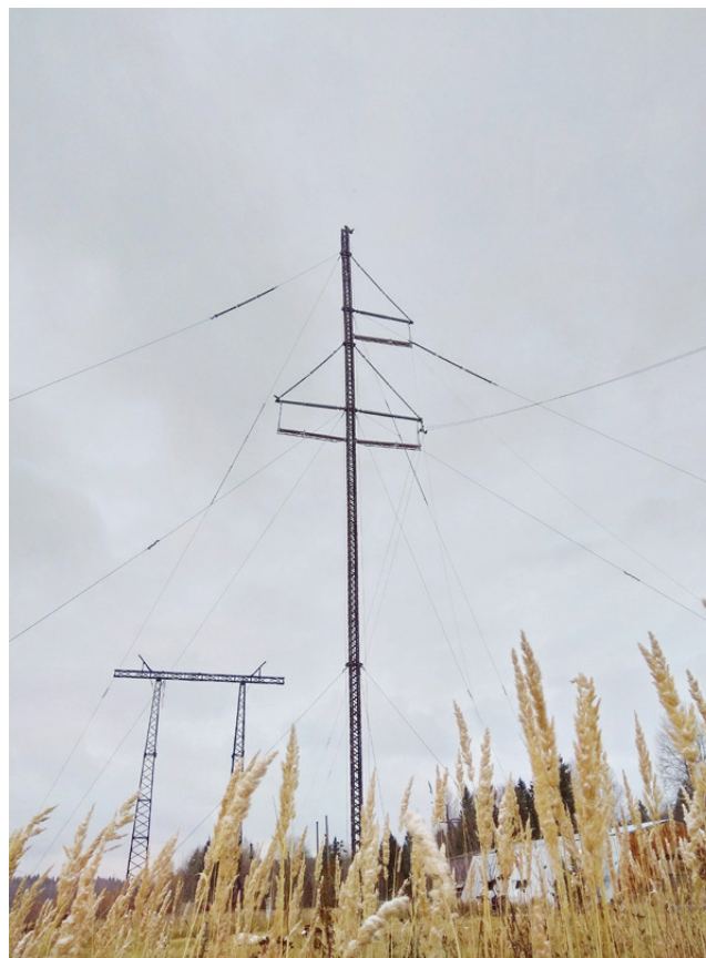
Рис. 6. Быстромонтируемая опора ВЛ 330 кВ
