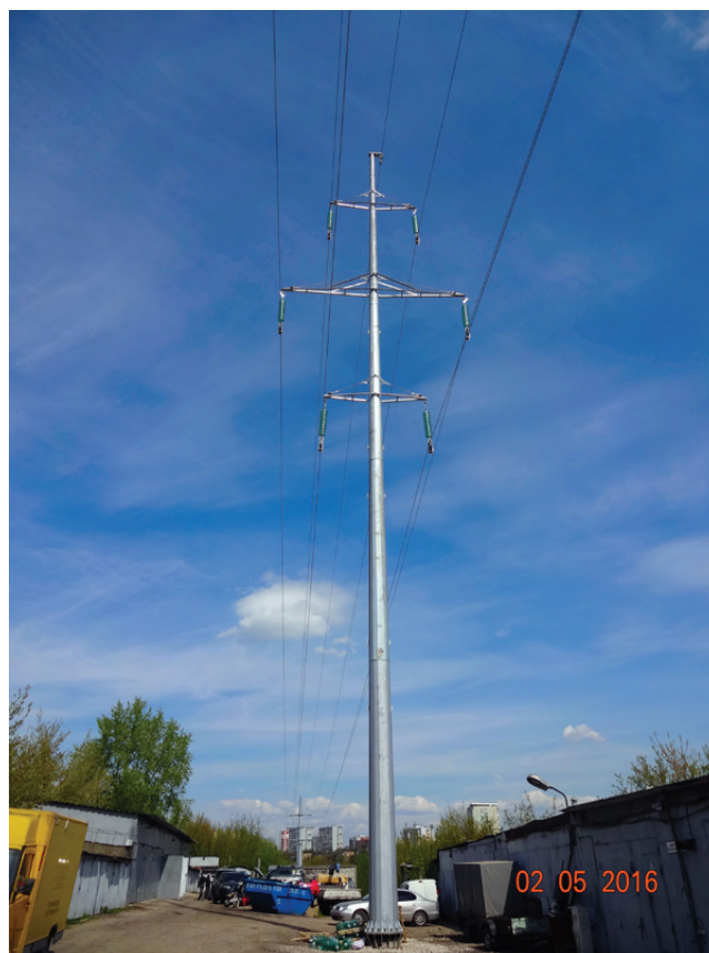
Рис. 2. Провод GZTACSR на многогранных опорах ВЛ 110 кВ ПС «Очаково» — ПС «Фили», Москва, 2016 г.
