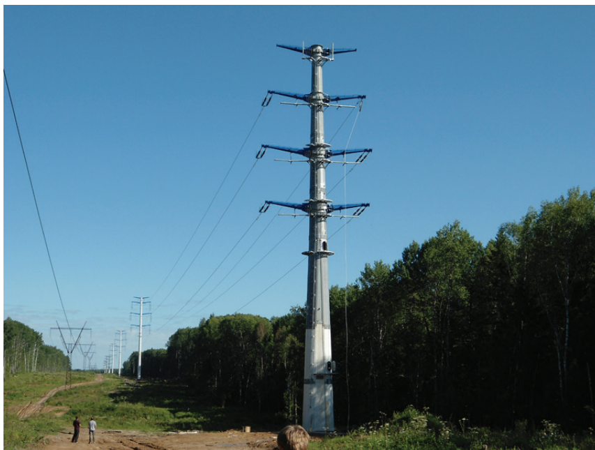
Рис. 1. Провод АССС® на многогранных опорах ВЛ 220 кВ ПС «Орбита» — ПС «Спутник», Калужская область, 2013 г.
