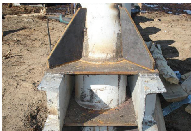
Рис. 1. Сварной узел соединения винтовой сваи с ростверком проекта серии 20006тм
