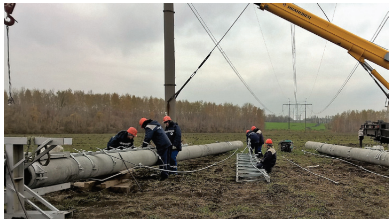
Рис. 1. Укрупнительная сборка стоек и сборки металлоконструкций
