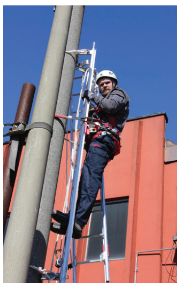
Рис. 9. Монтаж верхней секции
