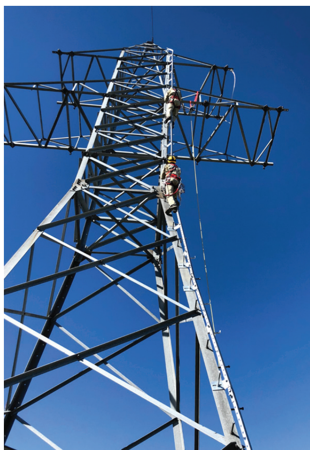
Рис. 3. Подъем по смонтированной опоре с ЖАЛ. ПС 110/10 Горенки
