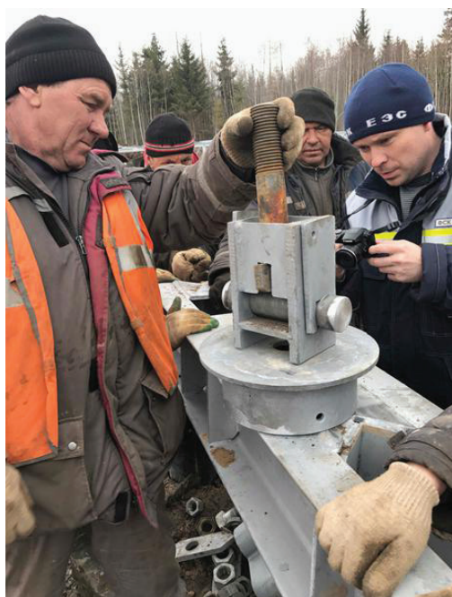
Рис. 5. Сборка фундамента под опору №99 ВЛ 750 кВ «Белозерская» — «Ленинградская»
