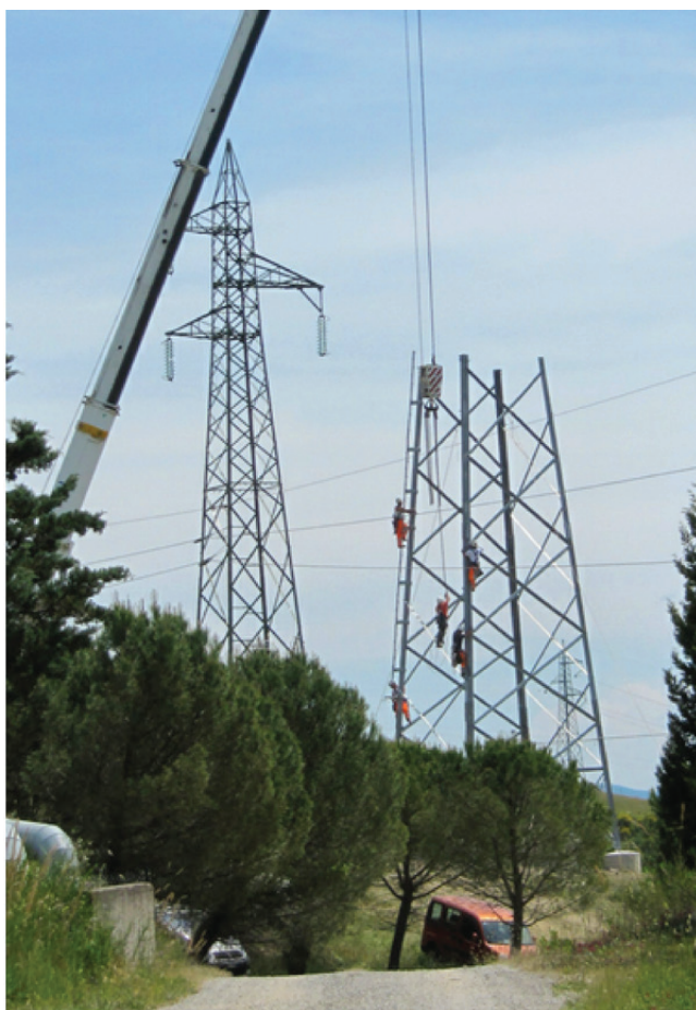
Рис. 2. Монтаж опоры с ЖАЛ
