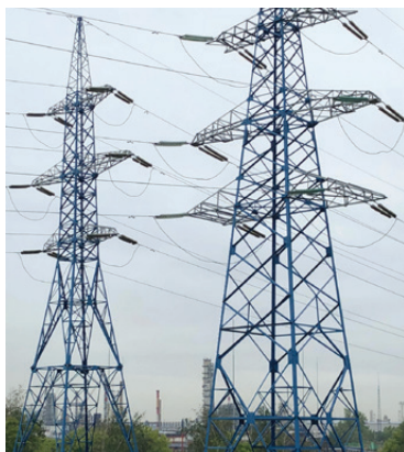
Рис. 20. Опоры на которых применимы для подъема штурмовые лестницы.
