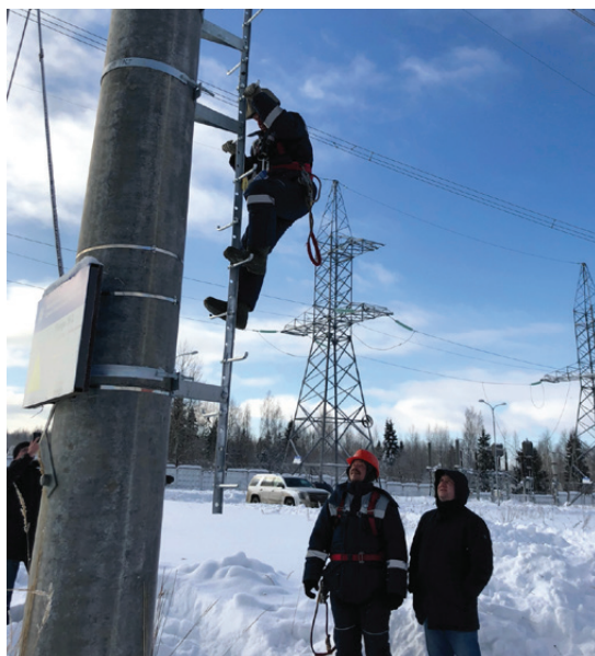
Рис. 8. Подъем по смонтированной опоре с ЖАЛ. ПС 110/10 Горенки
