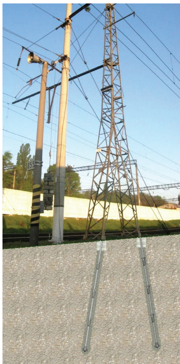
Рис. 1. Свайные фундаменты под опоры ВЛ с применением системы GEOIZOL-MP
