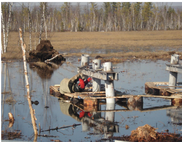
Рис. 2. Монтаж ВЛ 750 кВ «Ангара»-«Камала»
