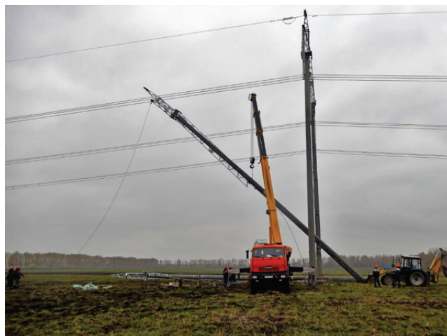
Рис. 2. Установка стойки опоры ПБ500-5н(с) автокраном
