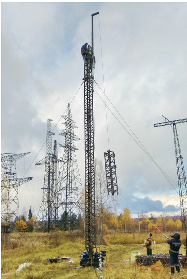
Рис. 3. Посекционное наращивание стойки.
