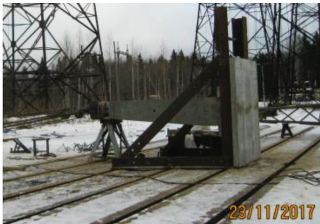
Рис. 2. Испытания фундаментов ФМ3-32.20.20-1Ш и ФМ4-32.20.20-1Б (Ф1 и Ф2) на растягивающие нагрузки
