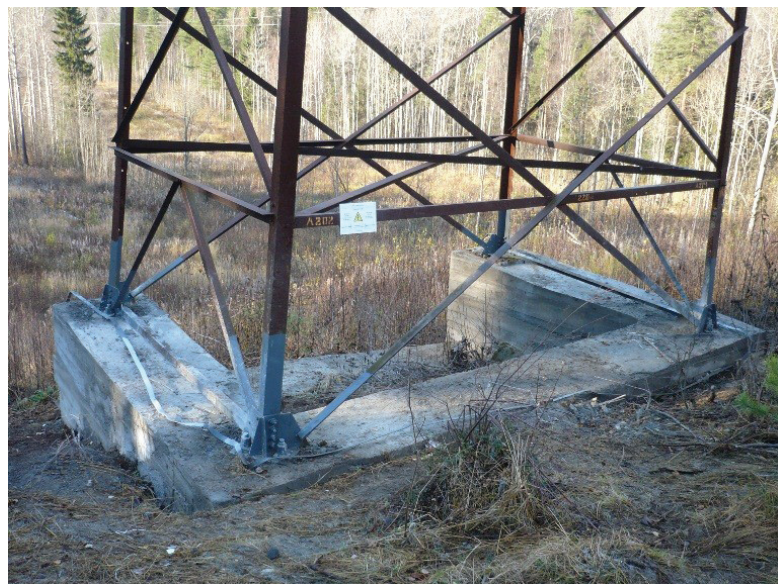
Рис. 5. Усиленный П-образный монолитный фундамент
