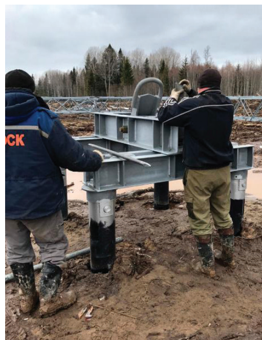
Рис. 5. Сборка фундамента под опору №99 ВЛ 750 кВ «Белозерская» — «Ленинградская»
