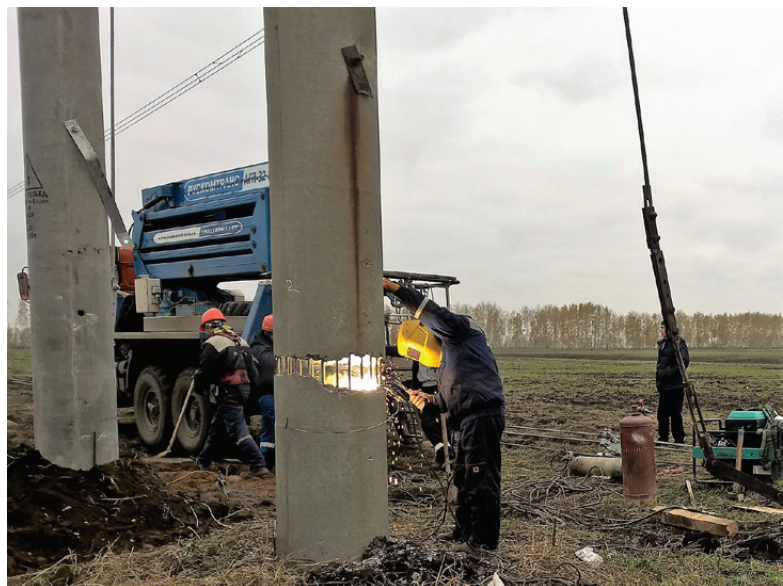
Рис. 5. Демонтаж стойки старой центрифугированной опоры
