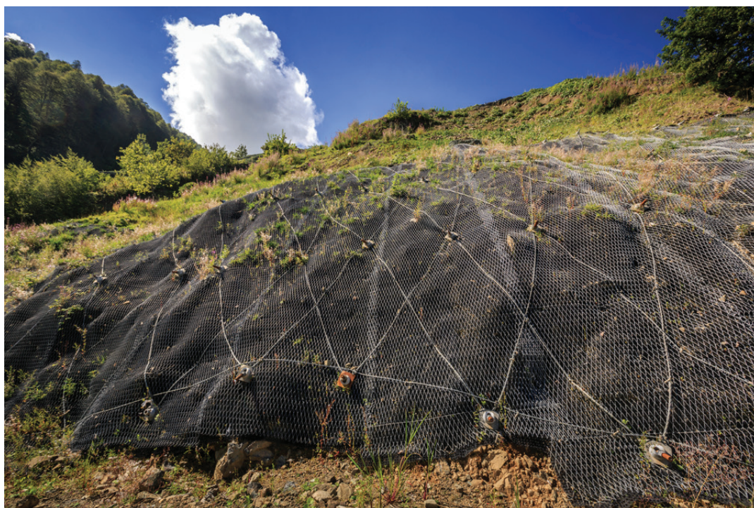
Рис. 3. Нагельное крепление склона с противоэрозионной защитой канатно-сетчатой системой
