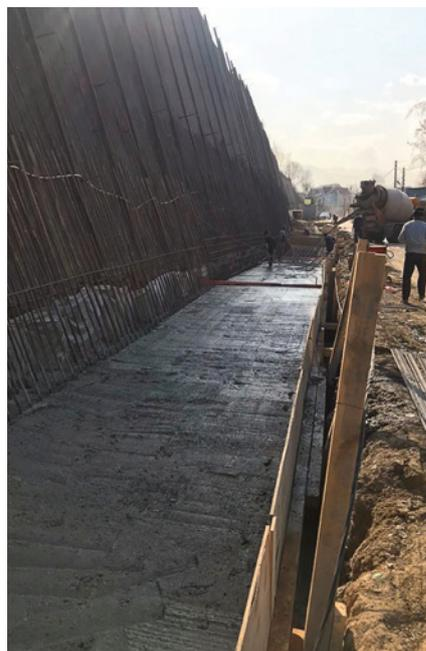
в) бетонирование плиты подпорной стены
