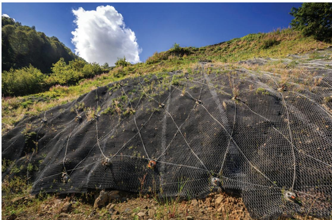
Рис. 5. Нагельное крепление склона с противозерозионной защитой канатно-сетчатой системой
