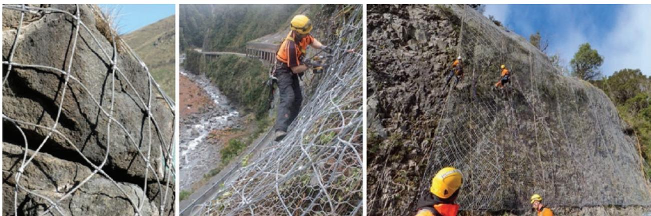
**Рис. 4.** Применение НЕА-панелей на сильнотрещиноватых склонах
