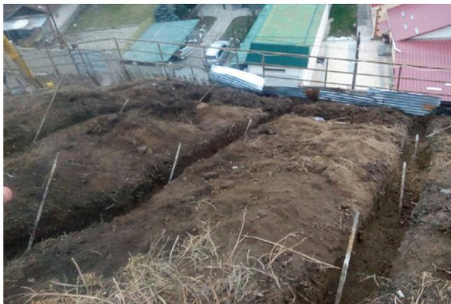
а) Установка грунтовых анкеров для закрепления решетчатых элементов
