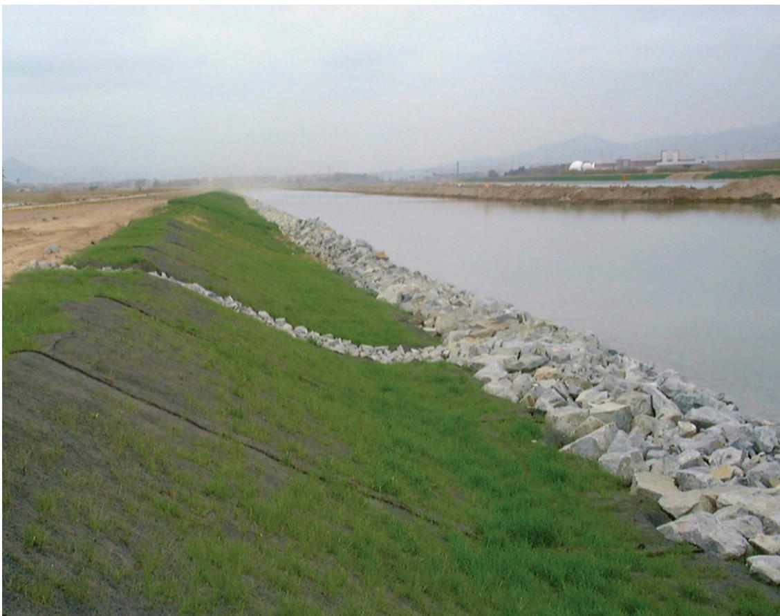
**Рис. 1.** Пример защиты откоса с применением материала Энкамат А20
