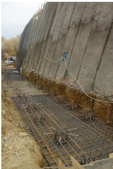
б) Подготовка наклонной поверхности и армирование плиты
