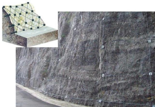
Рис. 2. Драпировка с дополнительным армированием
