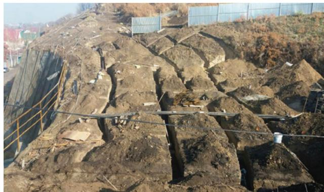
б) Подготовка территории для установки монолитных решетчатых элементов
