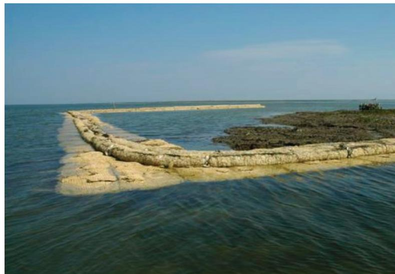
**Рис. 3.** Пример устройства защитной дамбы с применением материала «ГеоGRID-Мат» и монтаж материала в прибрежной зоне для защиты пляжей
