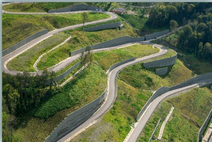
Свайная подпорная стена с анкерным креплением
