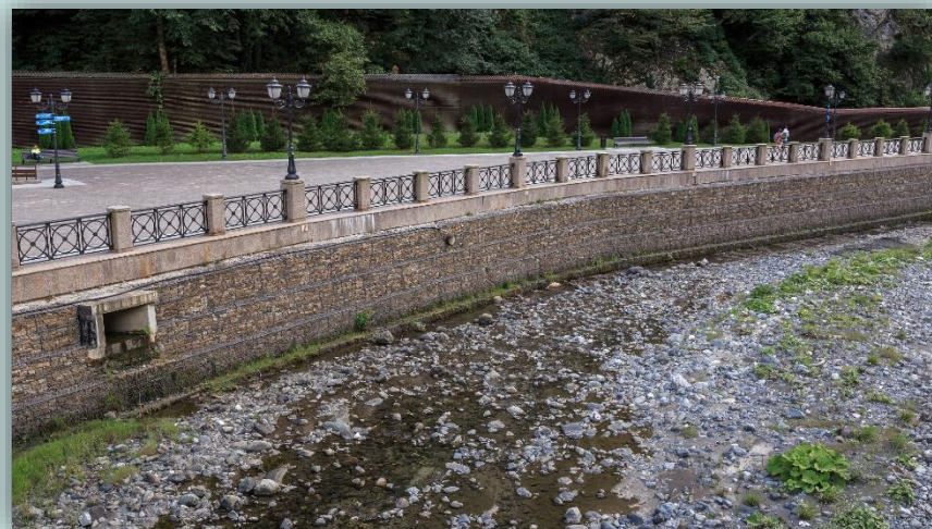
Подпорные стены из габионов
