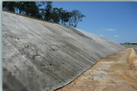
Нагельное крепление с торкретированием
