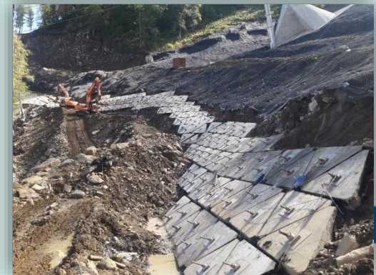
Анкерное крепление с прижимными плитами
