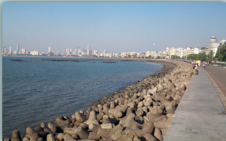
Гибкое волногасящее сооружение с применением тетраподов
