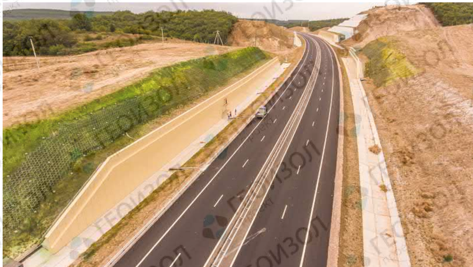
Гидропосев трав на участках с противозрозионной защитой. Трасса А-291 «Таврида», 7 этап
