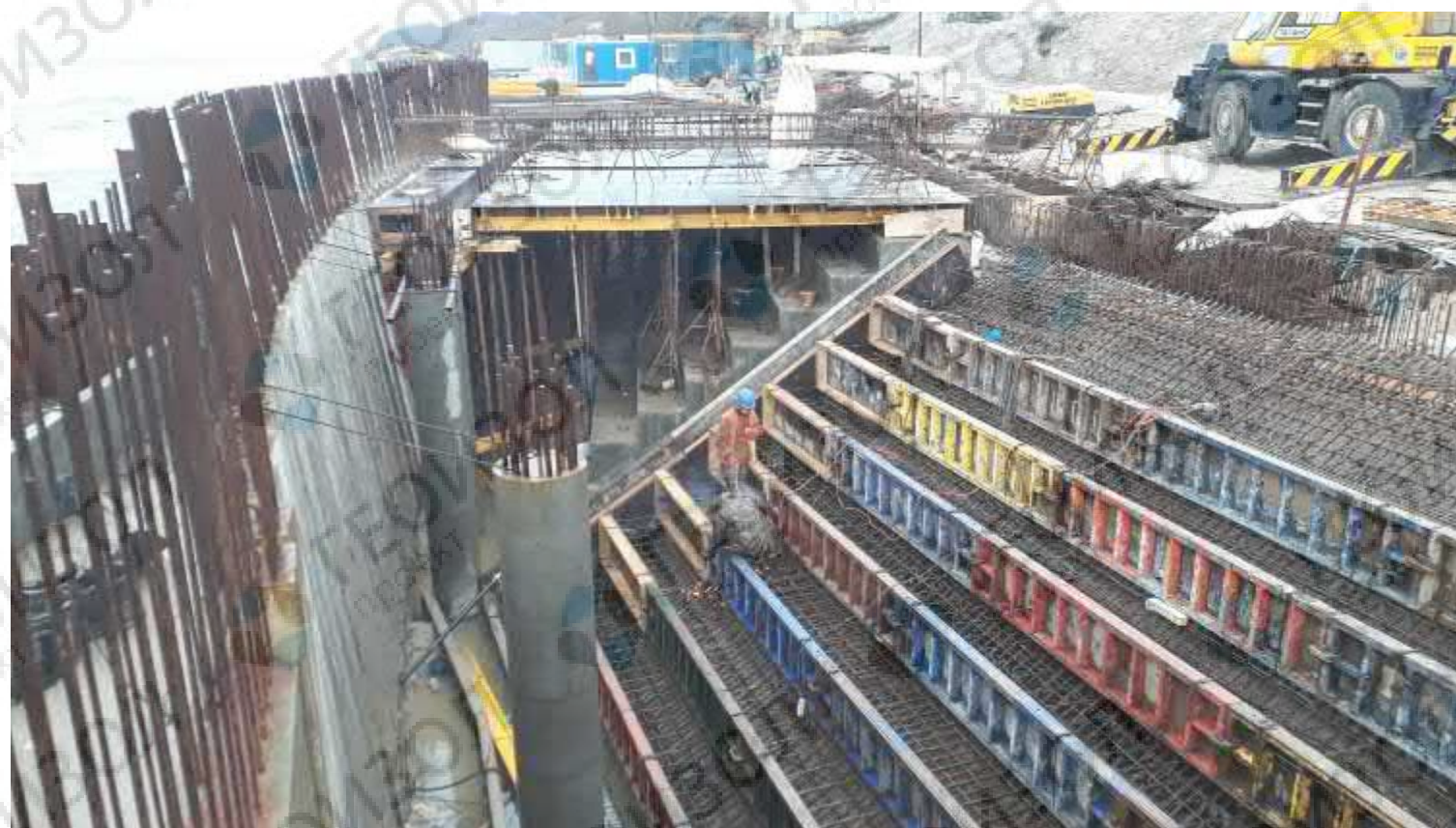
Бетонирование лестничной конструкции. Светлогорск, Калининградская область
