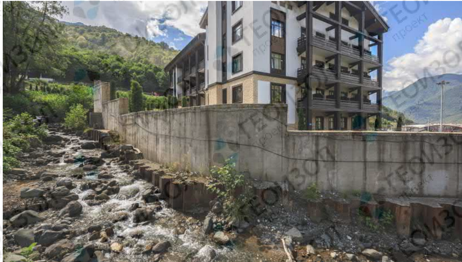
Шпунтовая стена для защиты береговой линии ручья Ржаной от размыва на станции канатных дорог «Альпика». Горнолыжный курорт «Альпика-Сервис», Сочи
