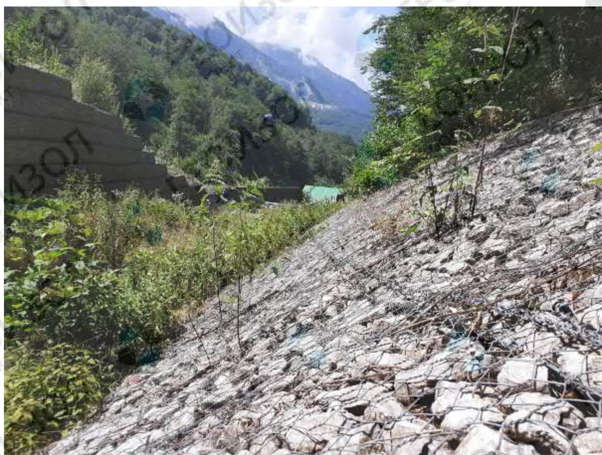
Укрепление берегов ручья Рудничный коробчатыми и матрасными габионами на склоне хребта Псехако. Горно-туристический центр «Газпром», Сочи
