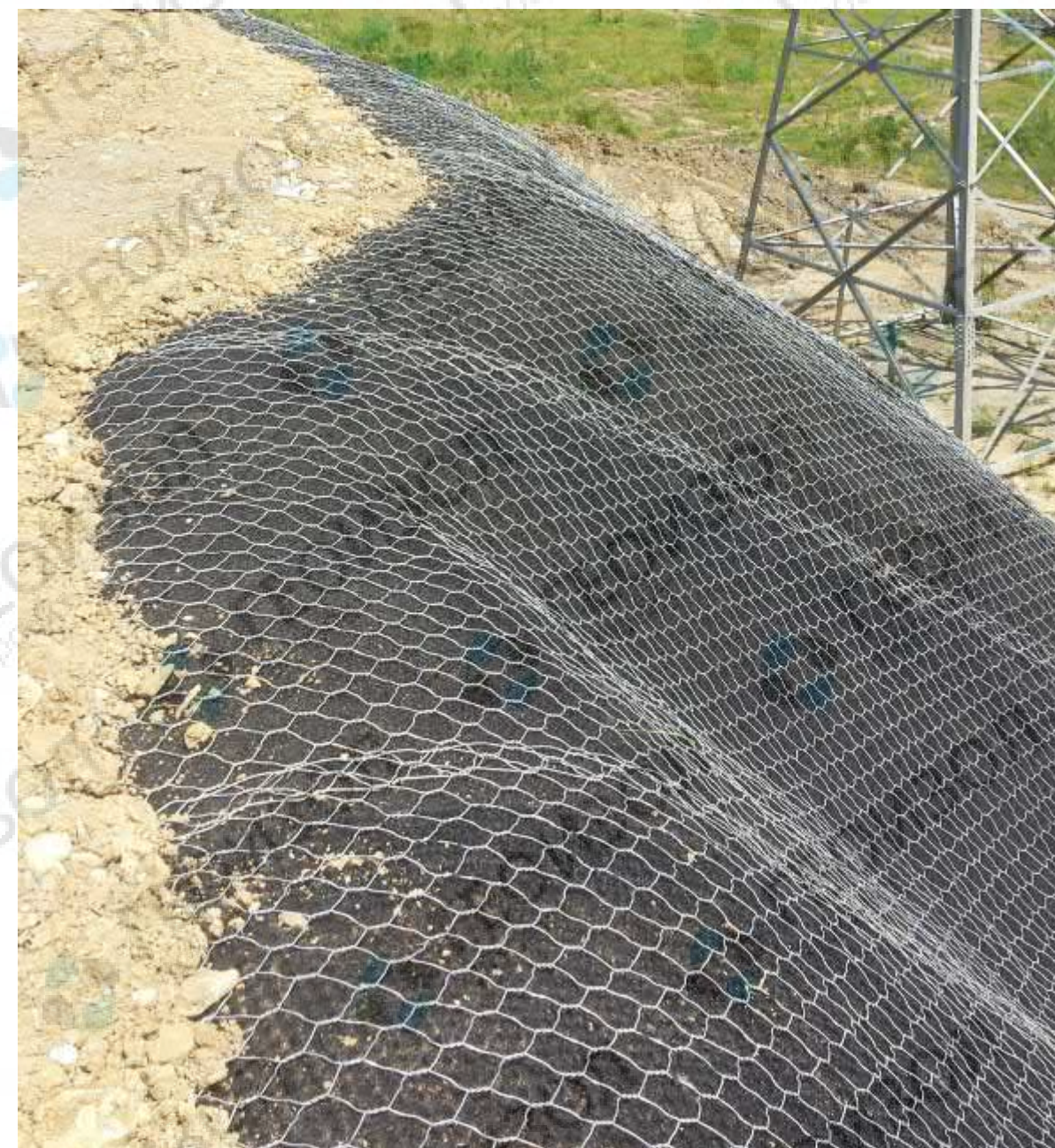
Устройство противозрозионной защиты в зоне расположения опор ЛЭП. Красноярск
