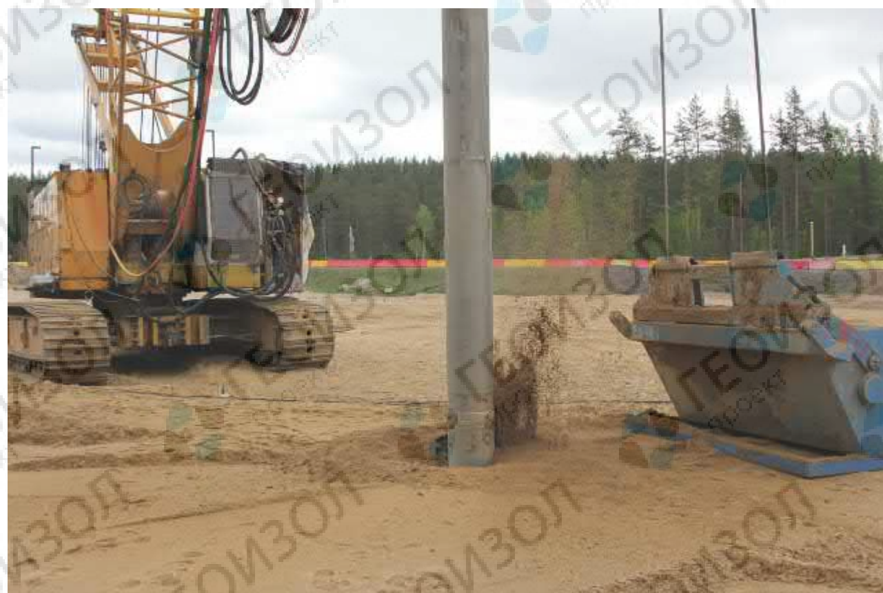
Устройство песчаных свай для прохождения заторфованного участка. Автодорога А-181 «Скандинавия», Ленинградская область
