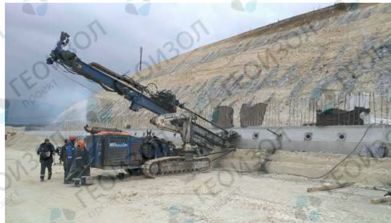
Самоходная буровая установка на гусеничном ходу
