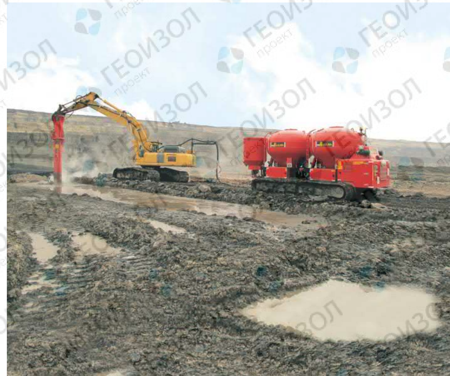
Процесс стабилизации грунтов основания с применением спецтехники финской компании ALLU
