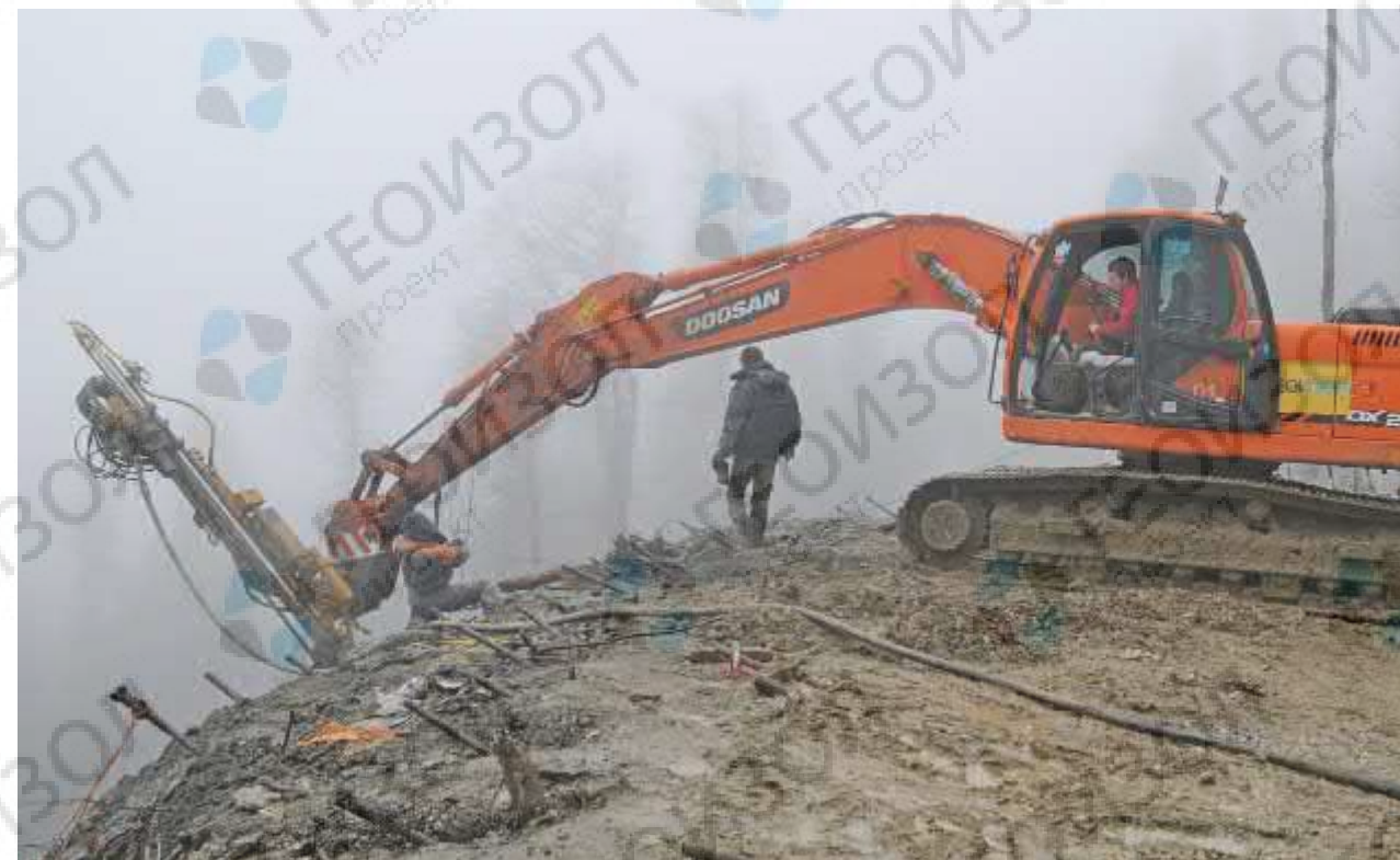
Навесное бурильное оборудование на базе экскаватора
