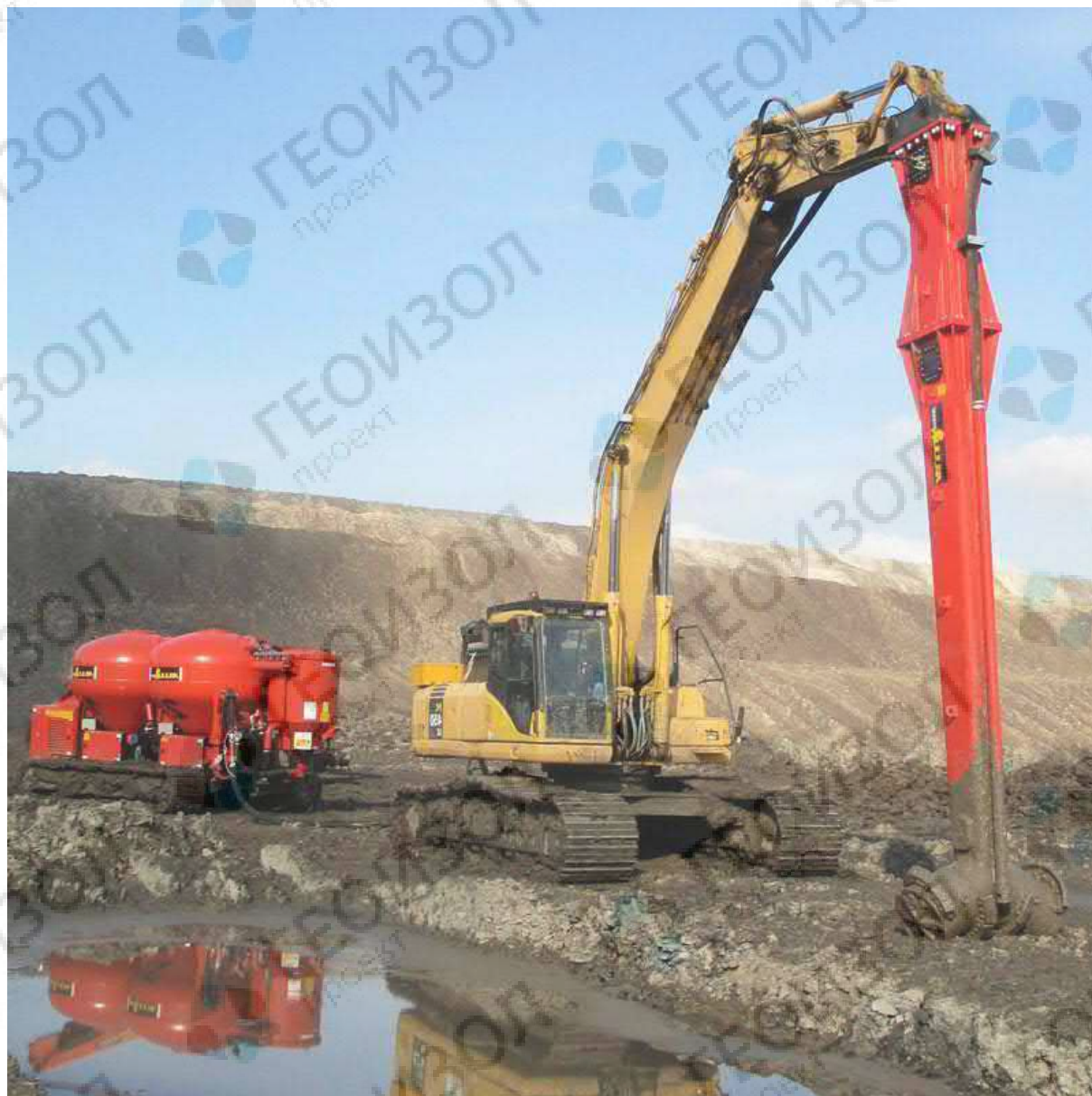
Процесс стабилизации грунтов основания с применением спецтехники финской компании ALLU
