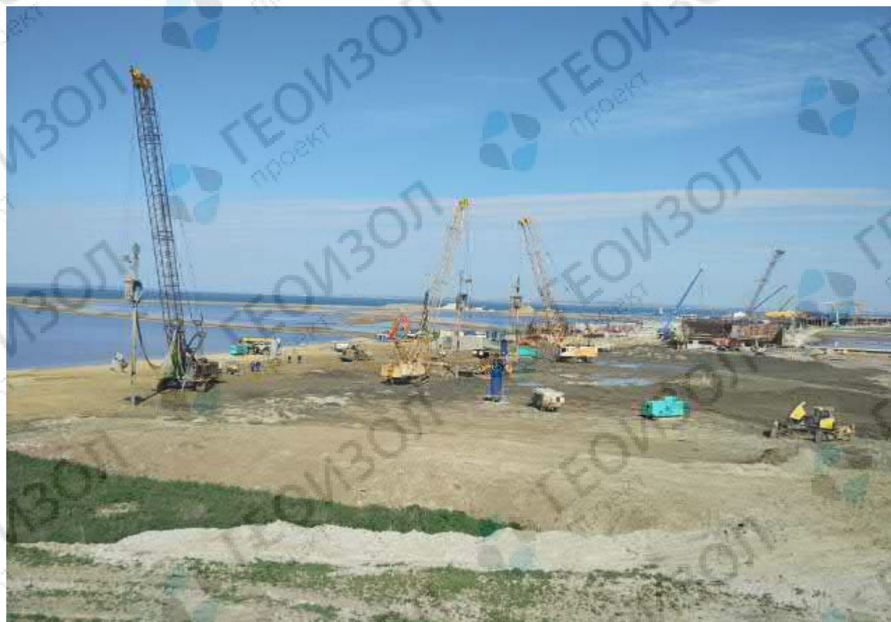
Усиление грунтов основания щебеночными сваями. Подход к Крымскому мосту, Тузлинская коса, Краснодарский край
