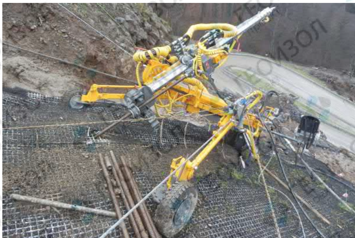
Мобильная буровая установка с тросовым креплением (альпинистское снаряжение) для работы на отвесных склонах
