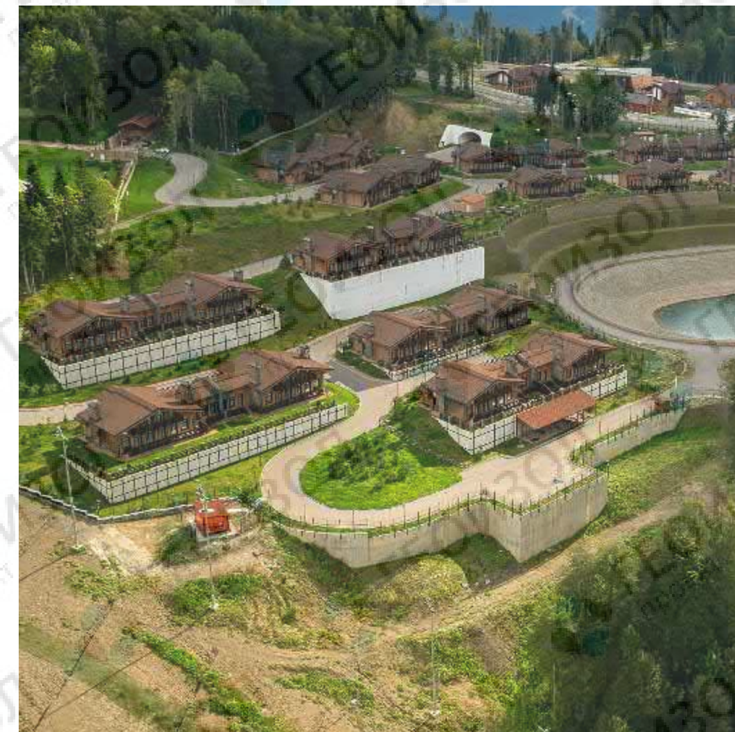
Коттеджи на склоне хребта Аибга, построенные на свайных основаниях, объединенных гибким ростверком. Горнолыжный курорт «Альпика-Сервис». Сочи
