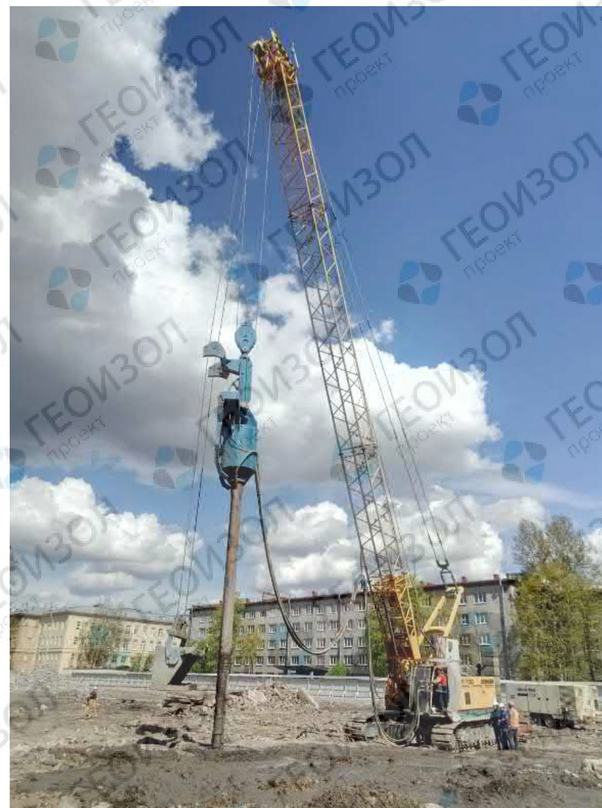
Устройство щебеночных свай для снижения деформативности грунтов основания. ЖК «Белый остров», Санкт-Петербург
