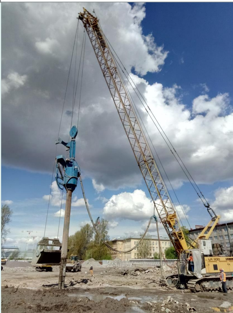
Процесс виброфлотации
