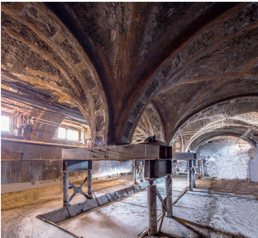
«Александровский дворец. Государственный музей-заповедник «Царское Село». Реконструкция, приспособление для современного использования. Вывешивание исторических колонн на буроинъекционные сваи GEOIZOL-MP с подведением новых фундаментов. Санкт-Петербург, г. Пушкин
