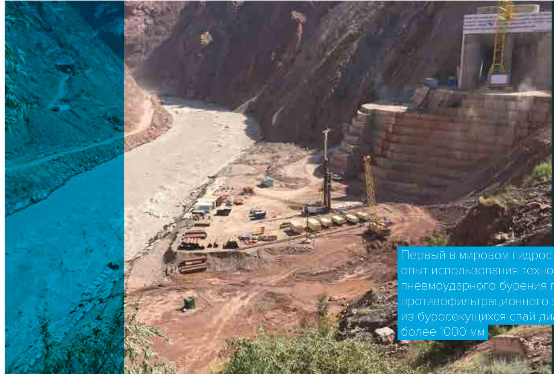
Первый в мировом гидростроении опыт использования технологии пневмоударного бурения при создании противофильтрационного элемента из буросекущихся свай диаметром более 1000 мм
