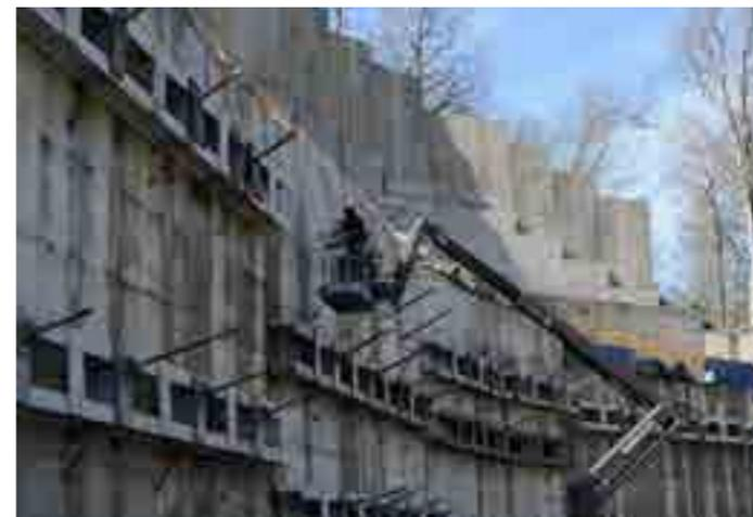
Для испытания анкеров было задействовано несколько телескопических погрузчиков и автокранов
