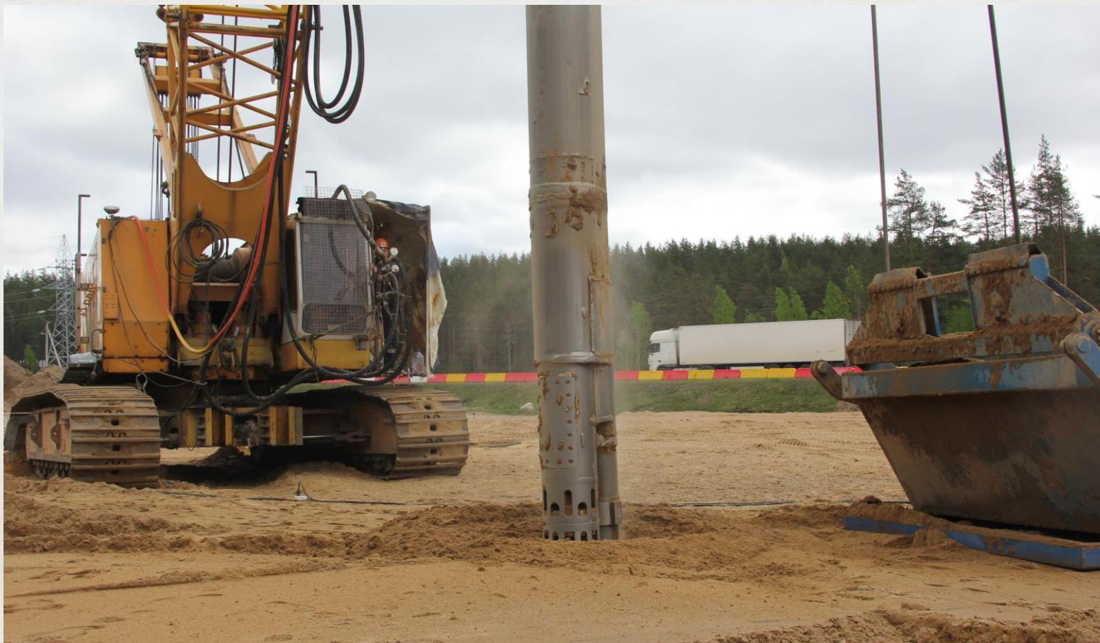
«Щебеночные (песчаные) сваи» – представляют собой технологию модификации грунтового массива путем формирования столбов из инертных материалов методом виброуплотнения.
