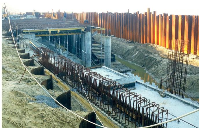
Рис.5 Этап монтажа плиты перекрытия эстакады
