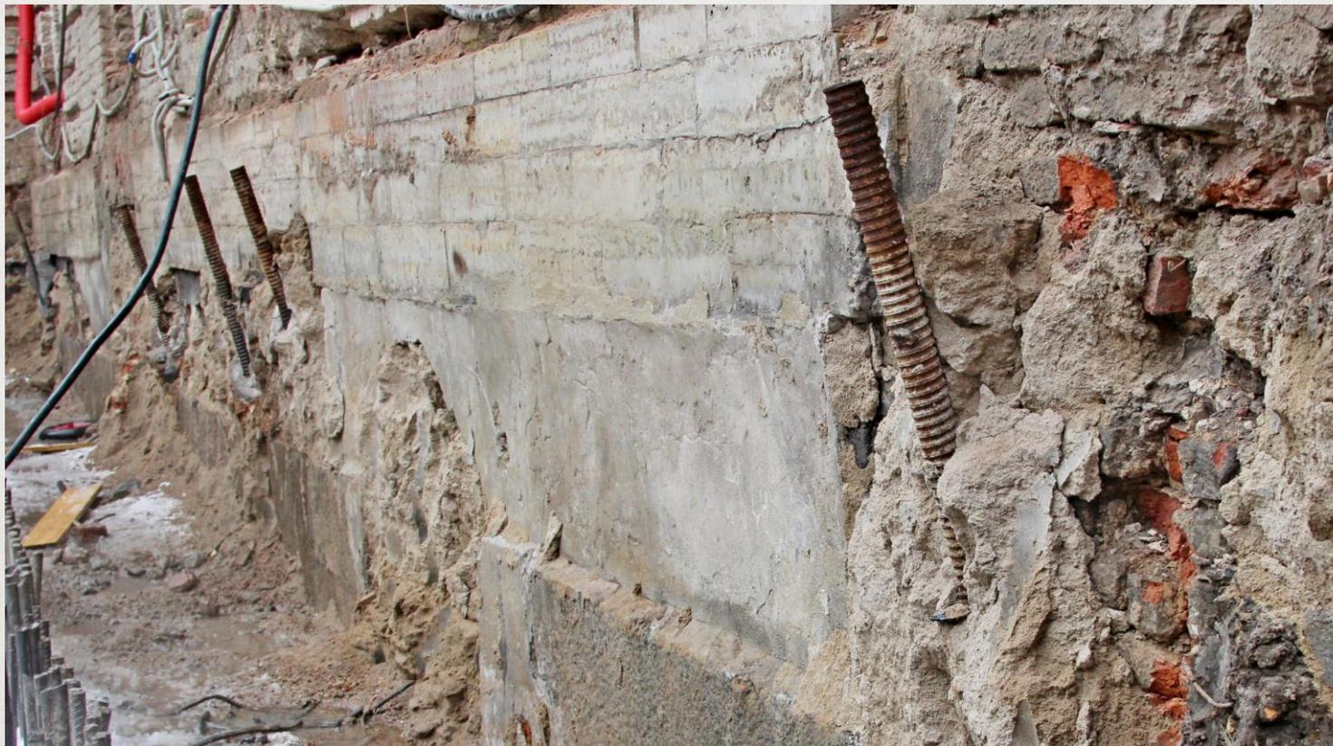
Перед устройством ограждающей конструкции выполнены мероприятия по усилению существующих фундаментов для исключения возможных осадок:
