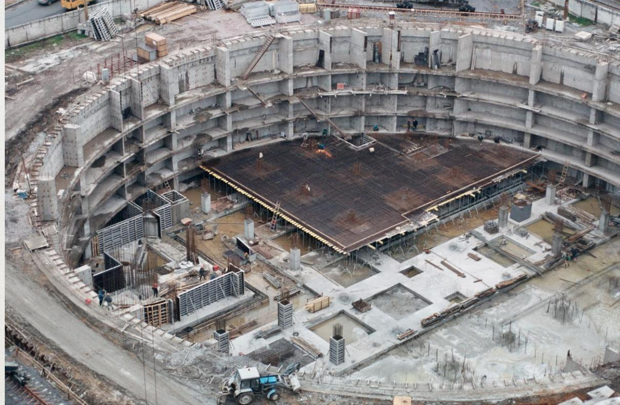
Устойчивость ограждающей конструкции обеспечивали железобетонные вертикальные и горизонтальные ребра жесткости, впоследствии включенные в состав межэтажных перекрытий.
