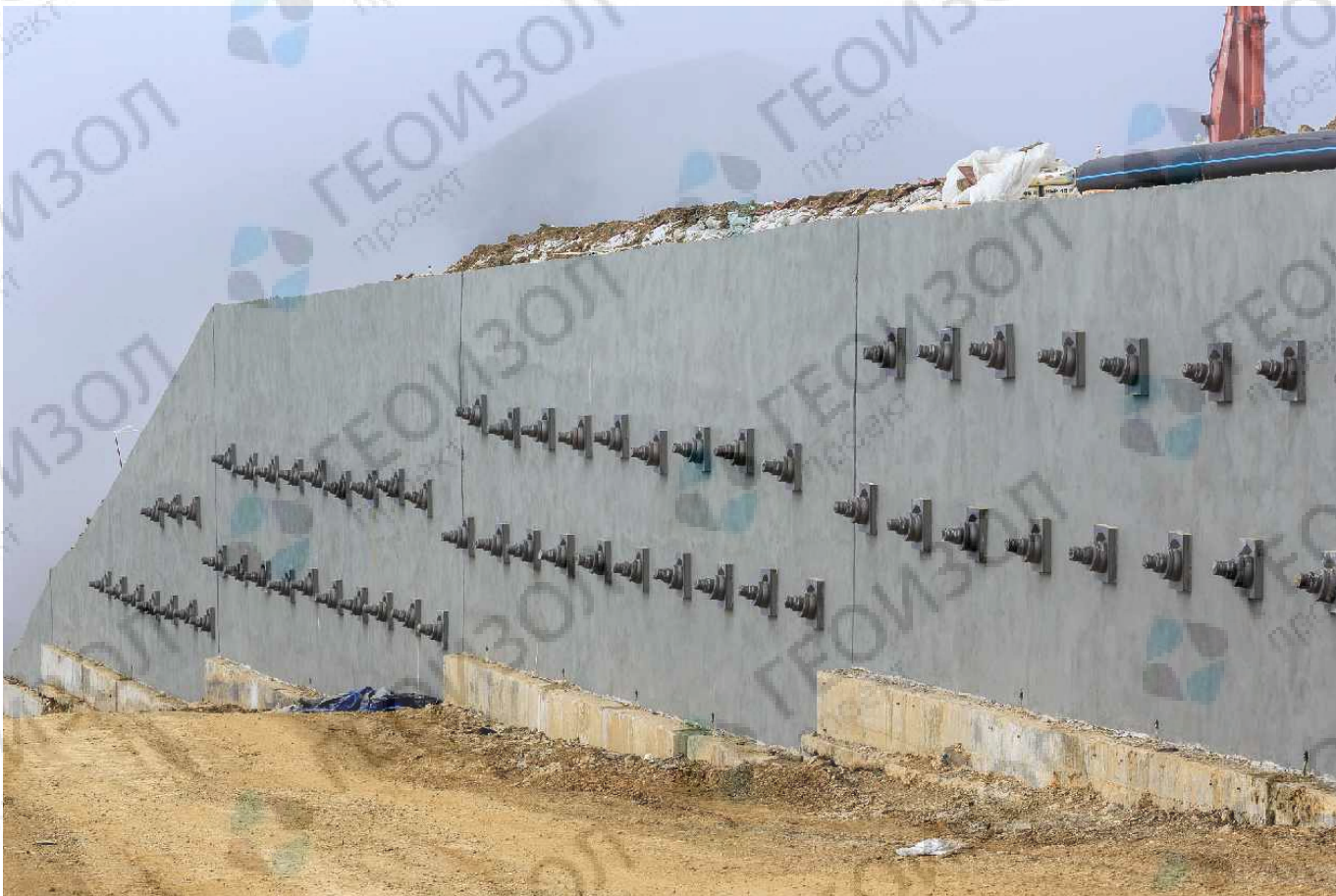
Подпорная стена на естественном основании с анкерным креплением. Горнолыжный курорт «Альпика-Сервис», ГТЦ «Газпром», Сочи
