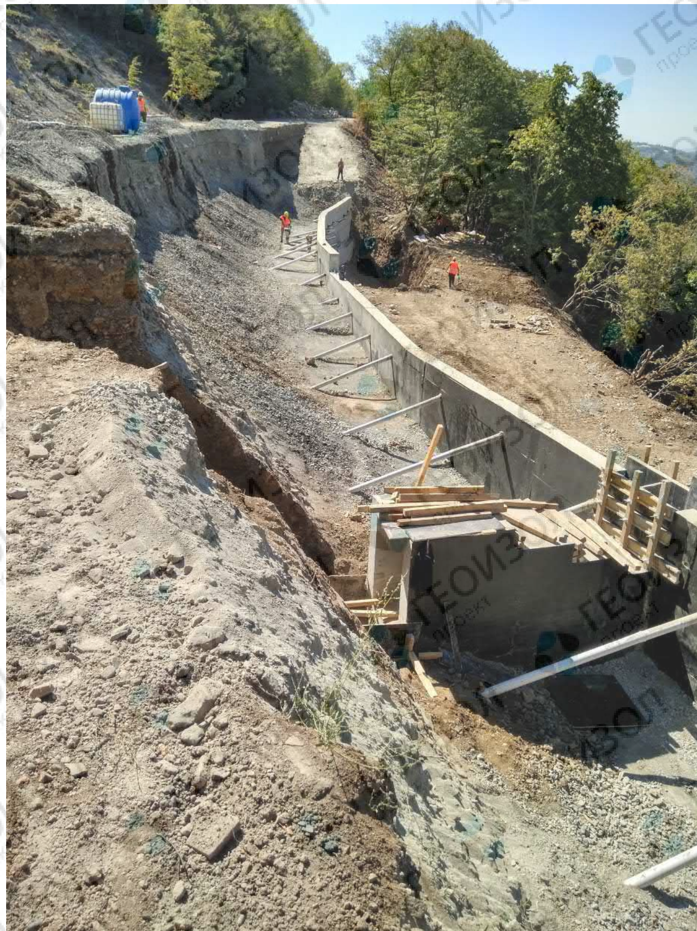
Строительство армогрунтовой стены при восстановлении участка автодороги Цхнети — Самадло после схода оползня. Грузия
