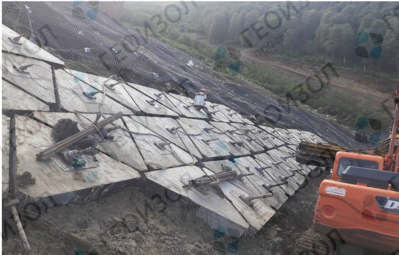
Укрепление склона прижимными плитами в комбинации с противозрозионным покрытием. Горнолыжный курорт «Альпика-Сервис», ГТЦ «Газпром», Сочи
