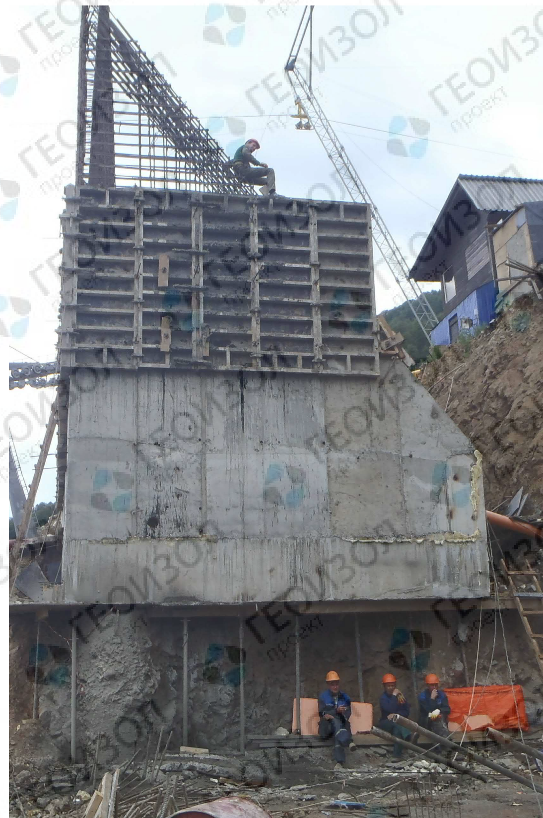
Возведение уголкового подпорной стены возле станции «Юность». Горнолыжный курорт «Альпика-Сервис», ГТЦ «Газпром», Сочи
