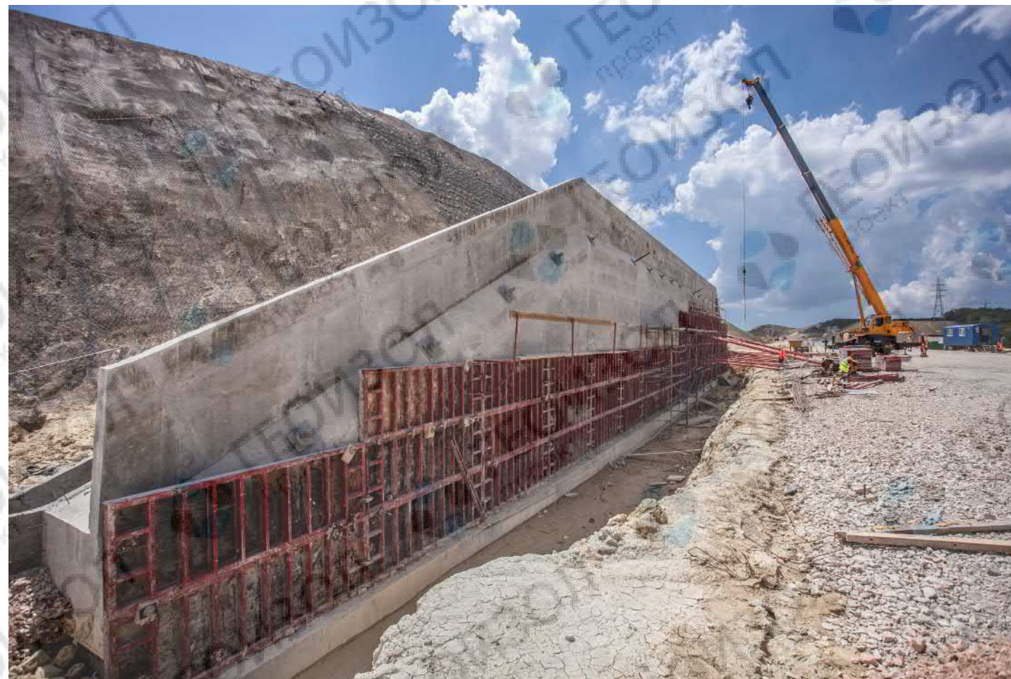
Строительство свайной подпорной стены (внизу слева) и общий вид удерживающих сооружений (внизу справа). Федеральная автодорога А-291 «Таврида» (7 этап), Крым
