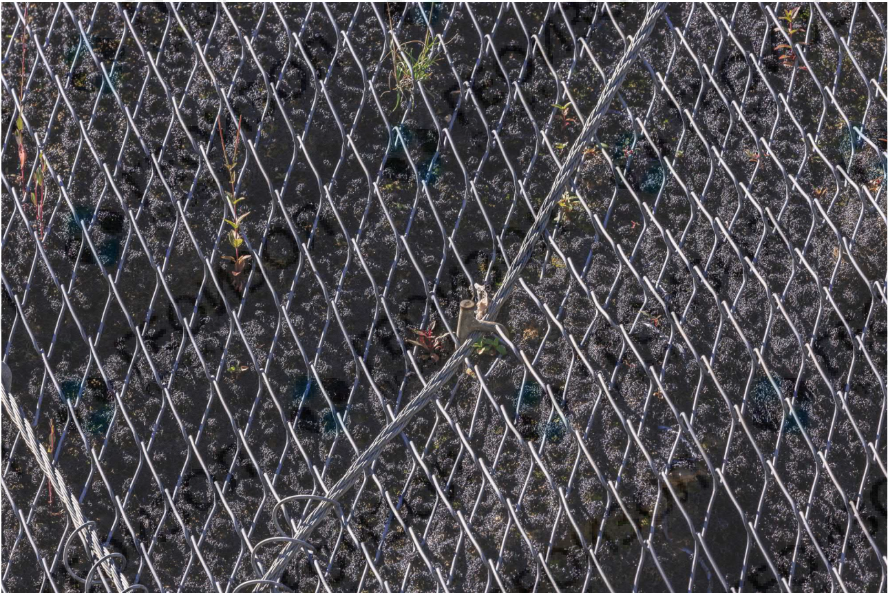
Узел крепления противозрозионной защиты забивным анкером. Сочи
