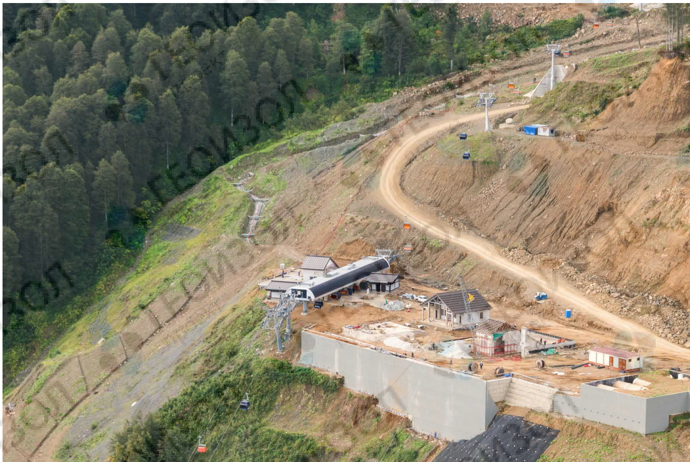
Прокладка инженерных сетей на склоне хребта Аибга возле станции канатных дорог «Юность» на отм. +1500 м (фото слева). Горнолыжный курорт «Альпика Сервис», ГТЦ «Газпром», Сочи
