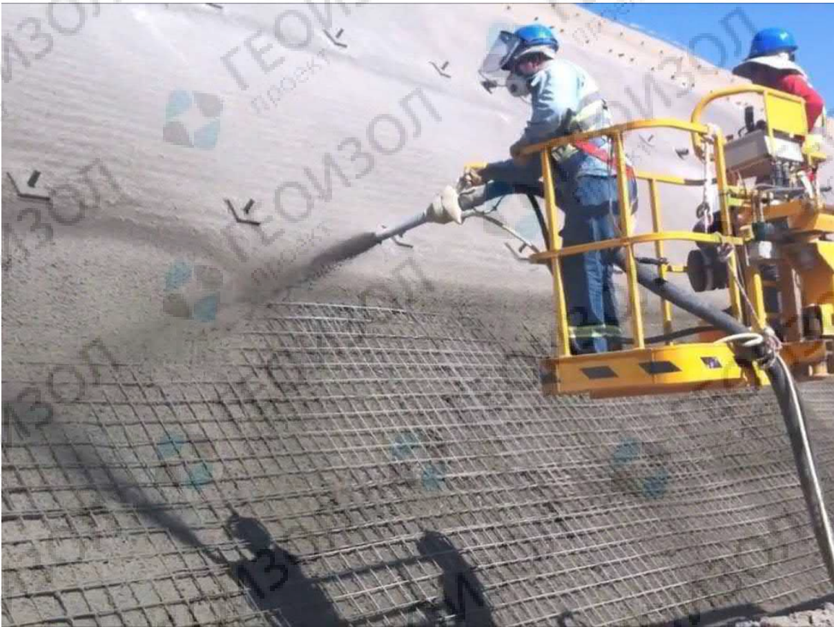
Производство строительно-монтажных работ по торкретированию склона компанией Doruk Engineering A.Ş. (Турция)
