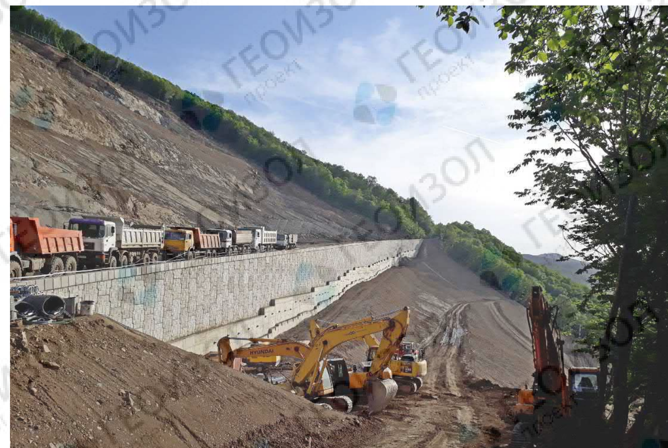
Общий вид армогрунтовой стены с облицовкой сборными железобетонными блоками. Участок автодороги Цхнети — Самадло, Грузия
