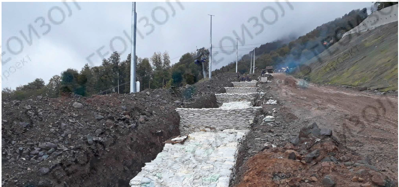
Сооружение поперечных водонепроницаемых барьеров (фото справа). ГТЦ «Газпром», Сочи
