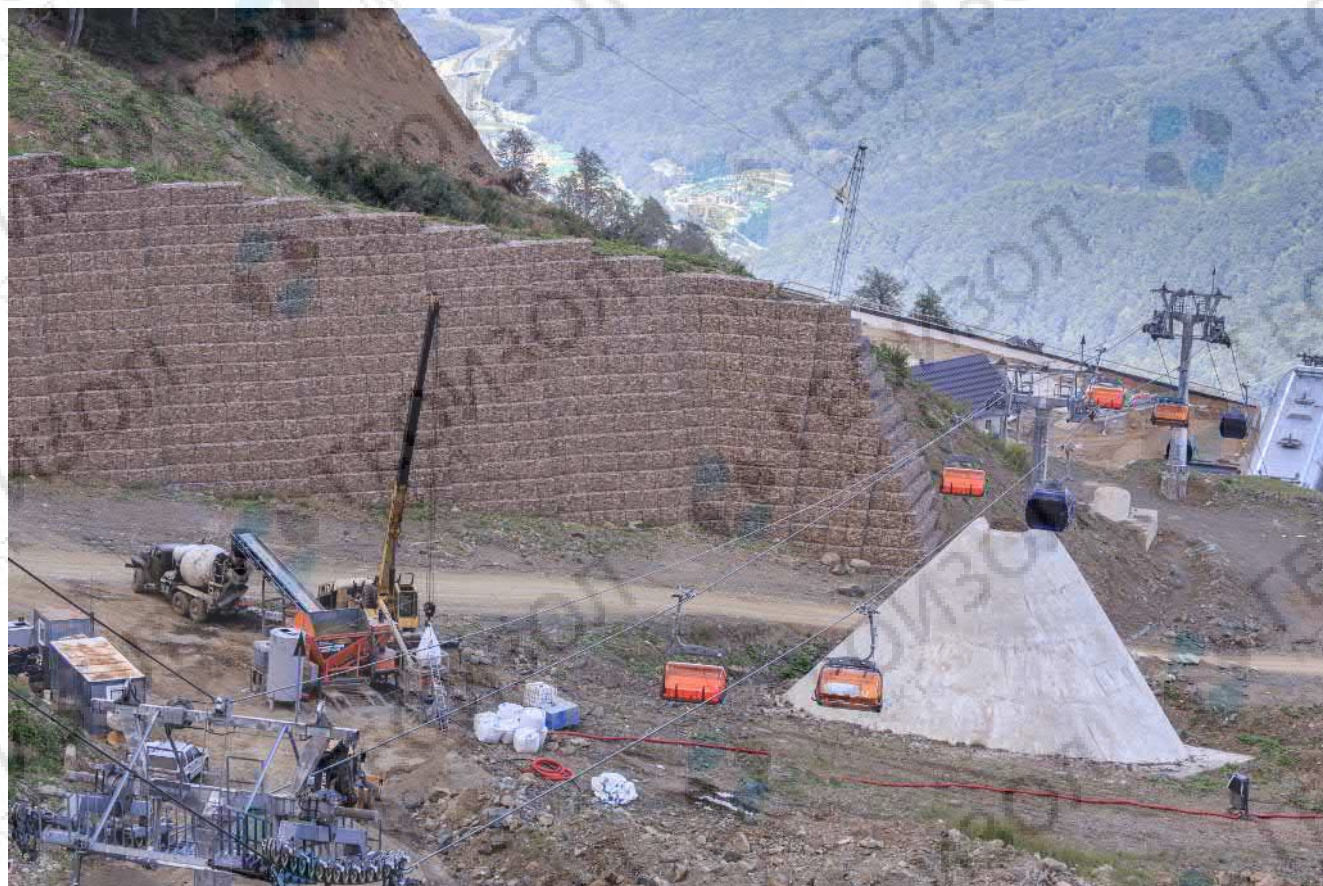
Подпорная стена из ГСИ, выполняющая роль лавинонаправляющей дамбы возле канатной дороги. Горнолыжный курорт «Альпика-Сервис», ГТЦ «Газпром», Сочи.
