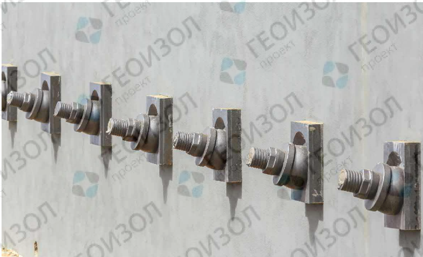
Узлы анкерного крепления крупным планом. Горнолыжный курорт «Альпика-Сервис», ГТЦ «Газпром», Сочи
