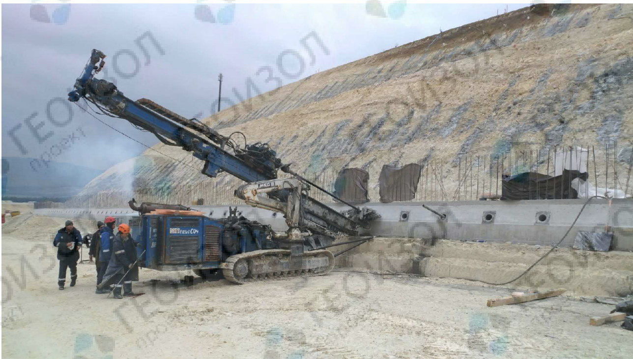
Самоходная буровая установка на гусеничном ходу
