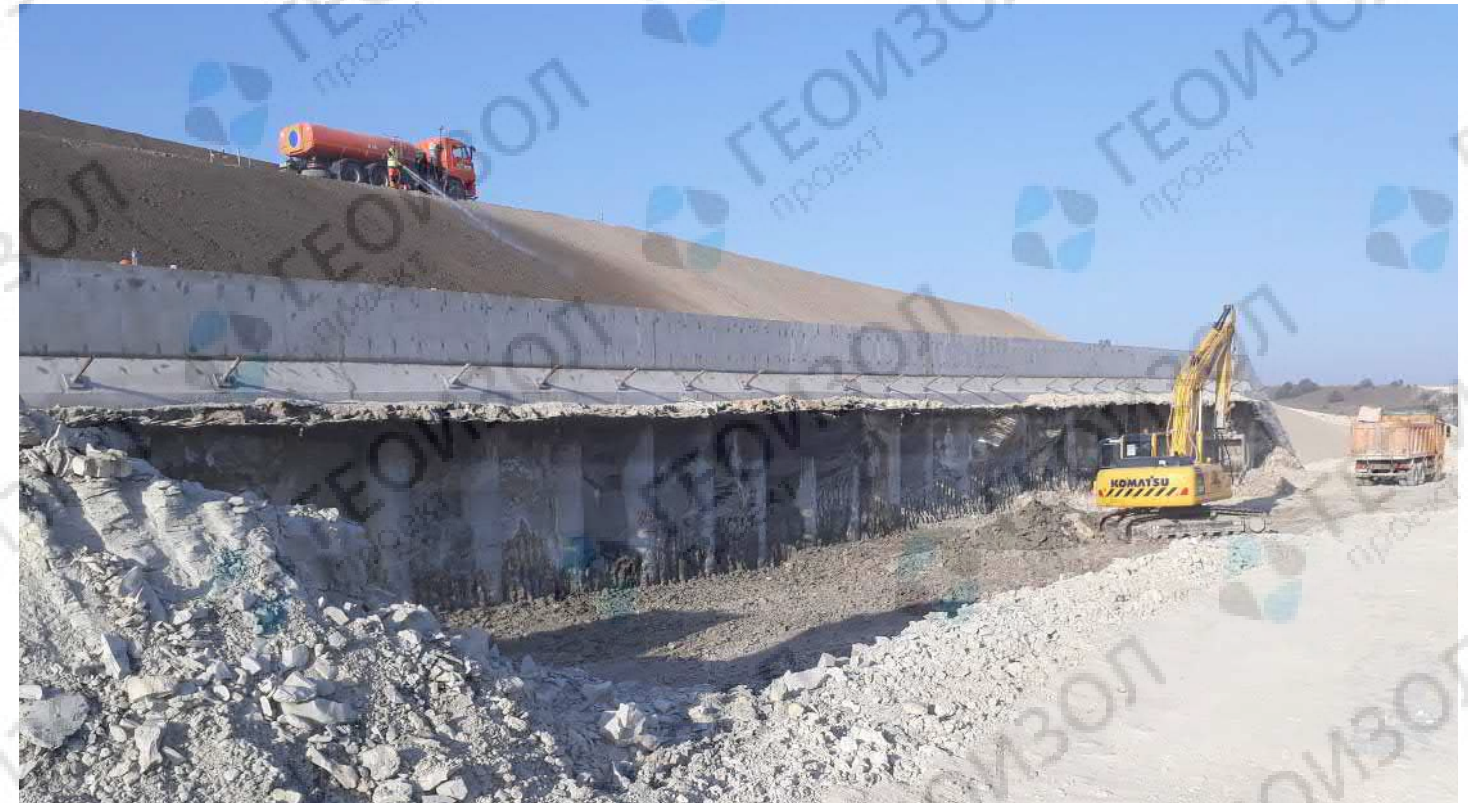
Разработка грунта возле свай перед омоноличиванием прижимной стенки. Федеральная автодорога А-291 «Таврида» (7 этап), Крым
