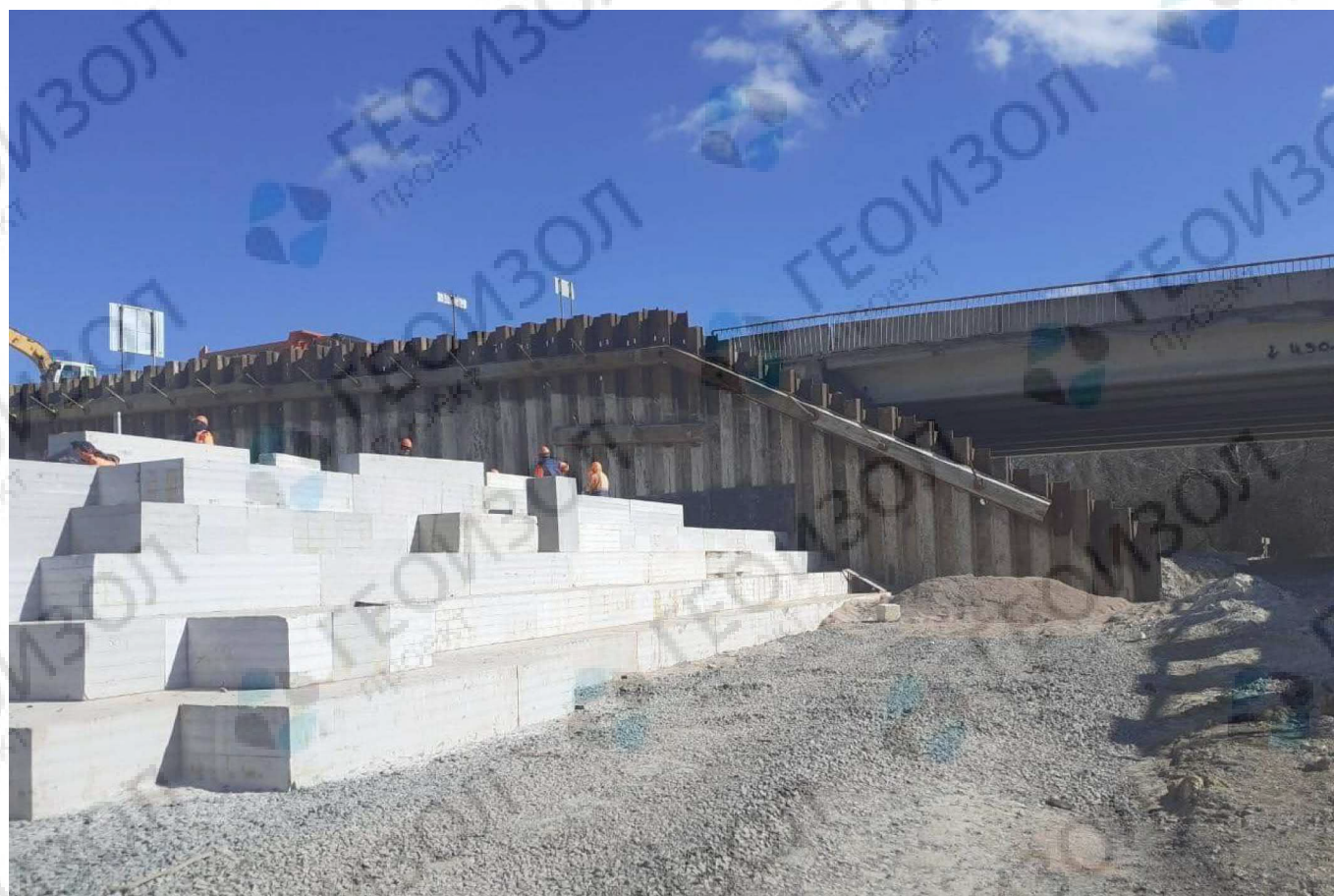
Использование шпунта в качестве ограждающей конструкции при возведении легкой насыпи. Федеральная автодорога А-291 «Таврида», Крым
