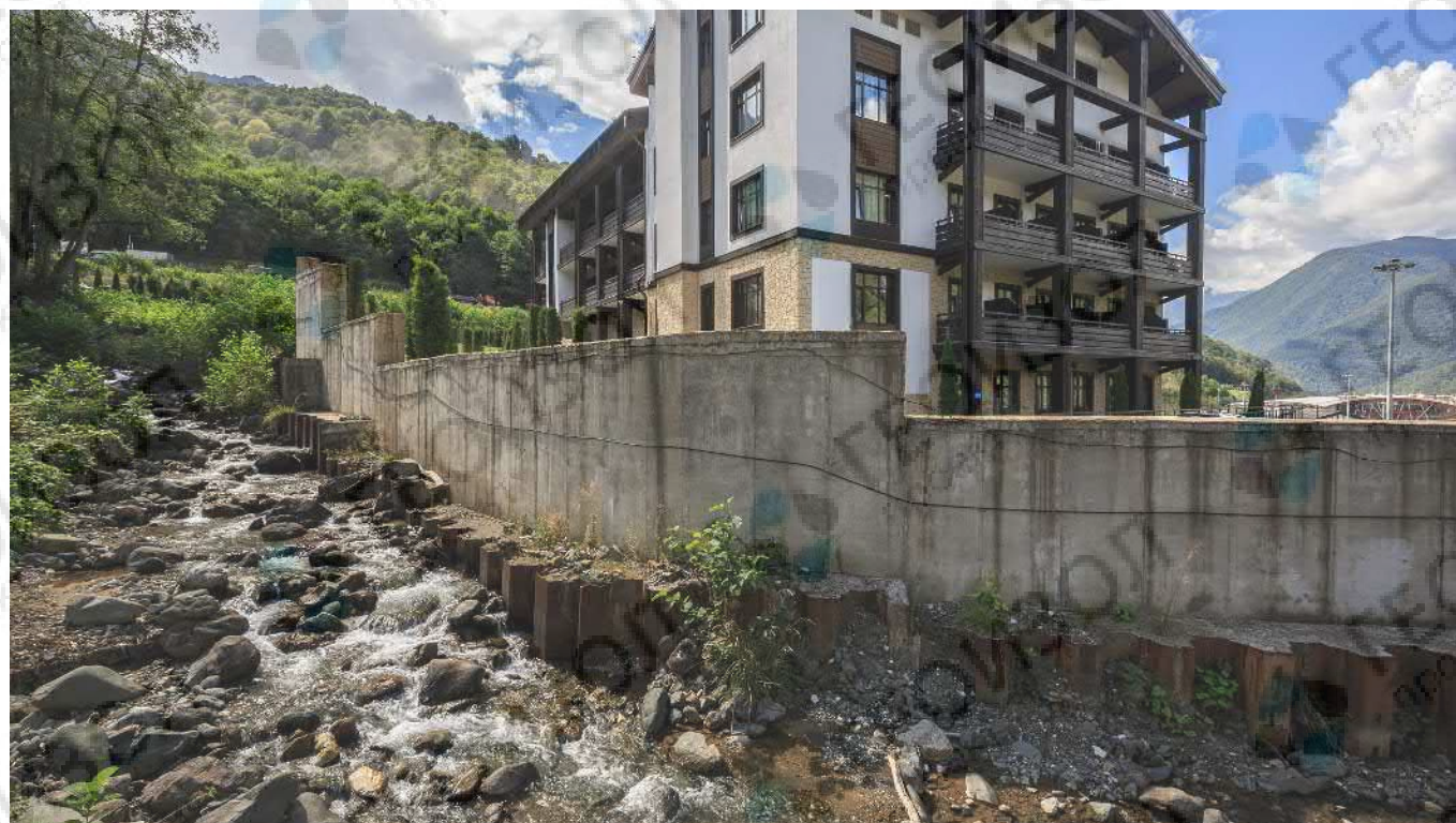
Ограждающая конструкция из двух рядов шпунта и прижимной бетонной стены служит в качестве берегоукрепления. Горнолыжный курорт «Альпика-Сервис», Сочи
