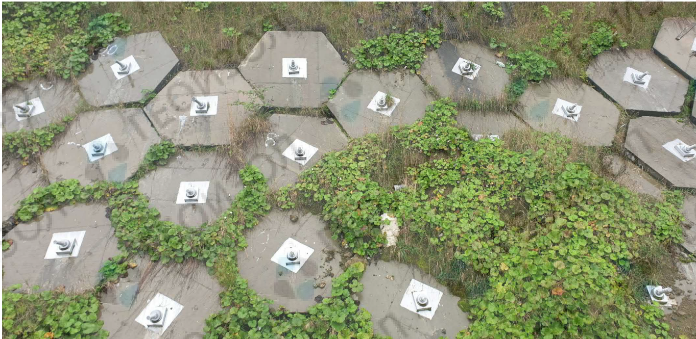
Анкерное крепление склона хребта Аибга спустя 6 лет эксплуатации. Горнолыжный курорт «Альпика-Сервис», ГТЦ «Газпром», Сочи
