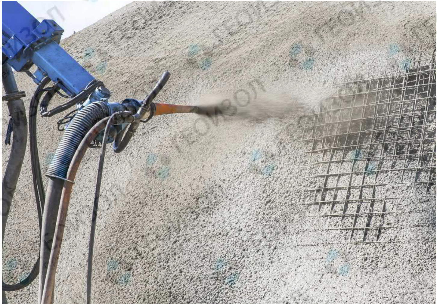
Пример торкретирования склона с применением арматурной сетки
