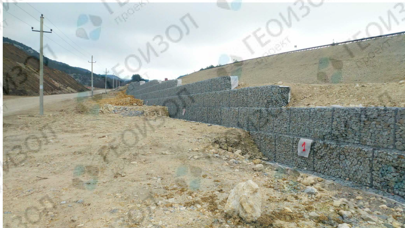
Строительство армогрунтовой подпорной стены с использованием габионов в качестве облицовки. Федеральная автодорога А-291 «Таврида» (8 этап), Крым.
