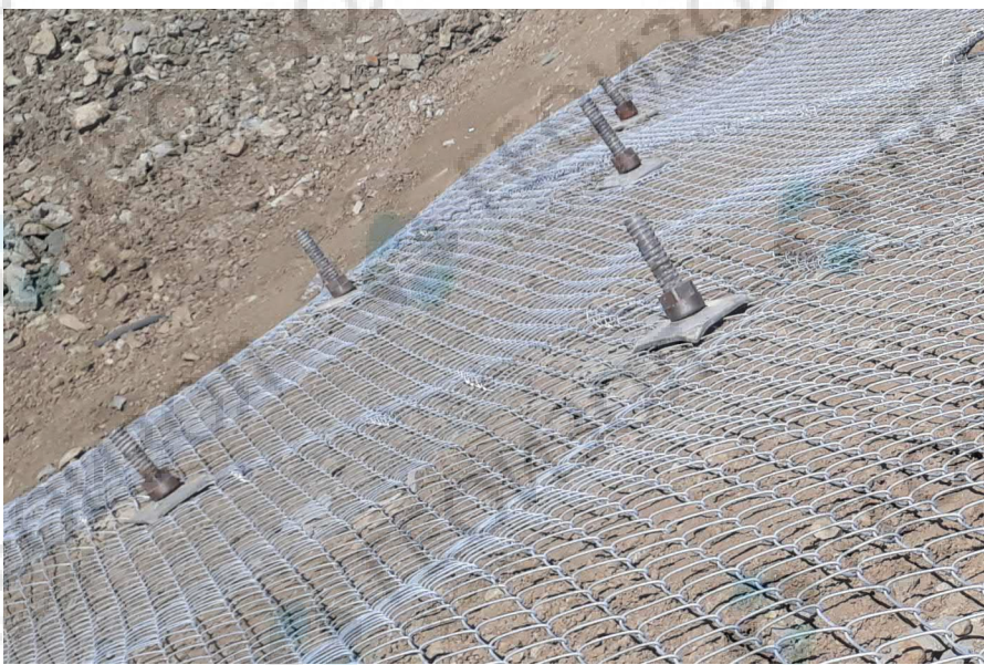
Узел с когтевой пластиной крупным планом
