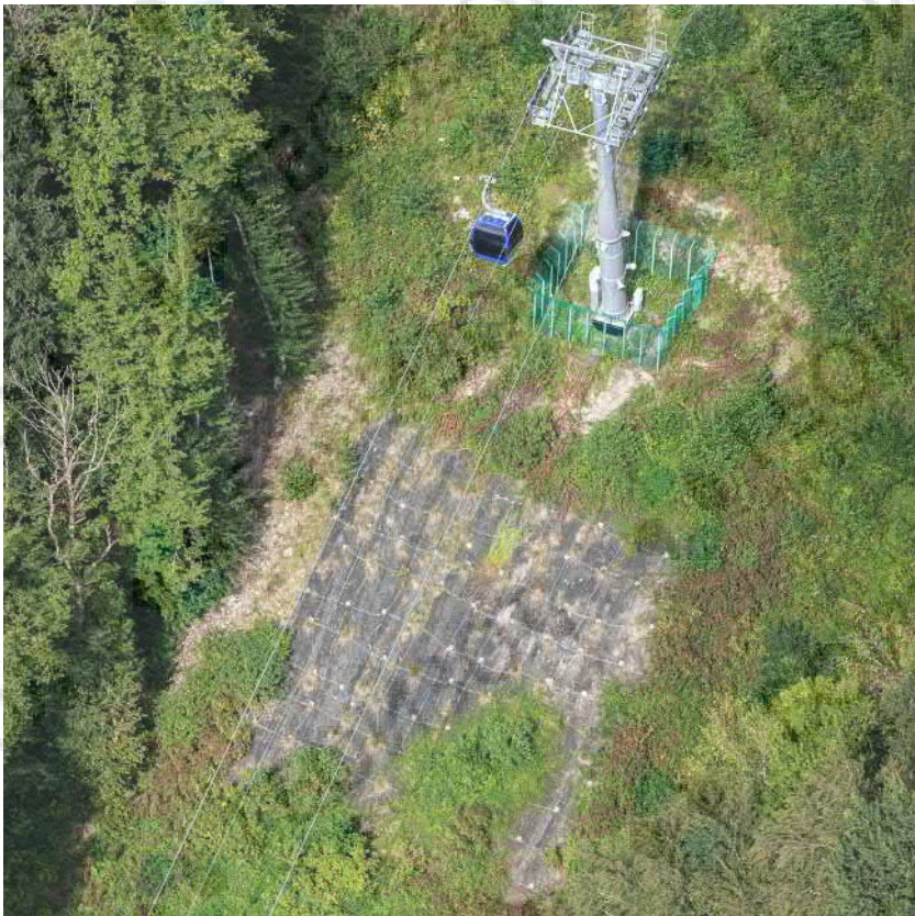
Нагельное поле, обеспечивающее устойчивость опор канатной дороги. Горнолыжный курорт «Лаура», ГТЦ «Газпром», Сочи
