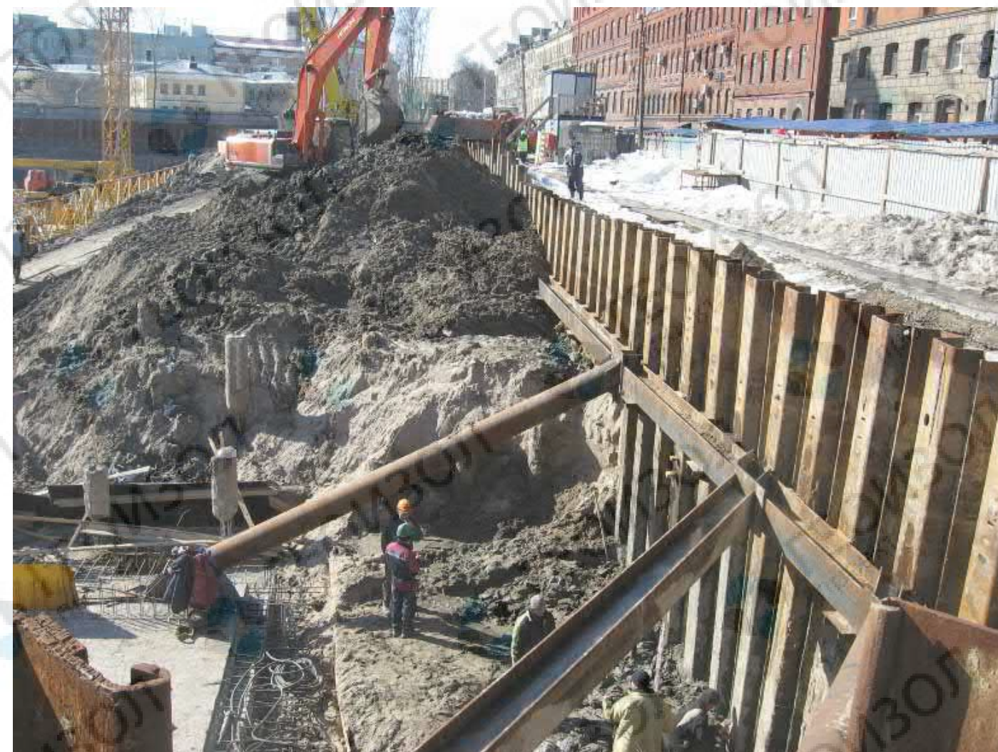
Шпунтовое ограждение котлована с использованием распорных конструкций вместо грунтовых анкеров. Корпусная ул., д.9, Санкт-Петербург
