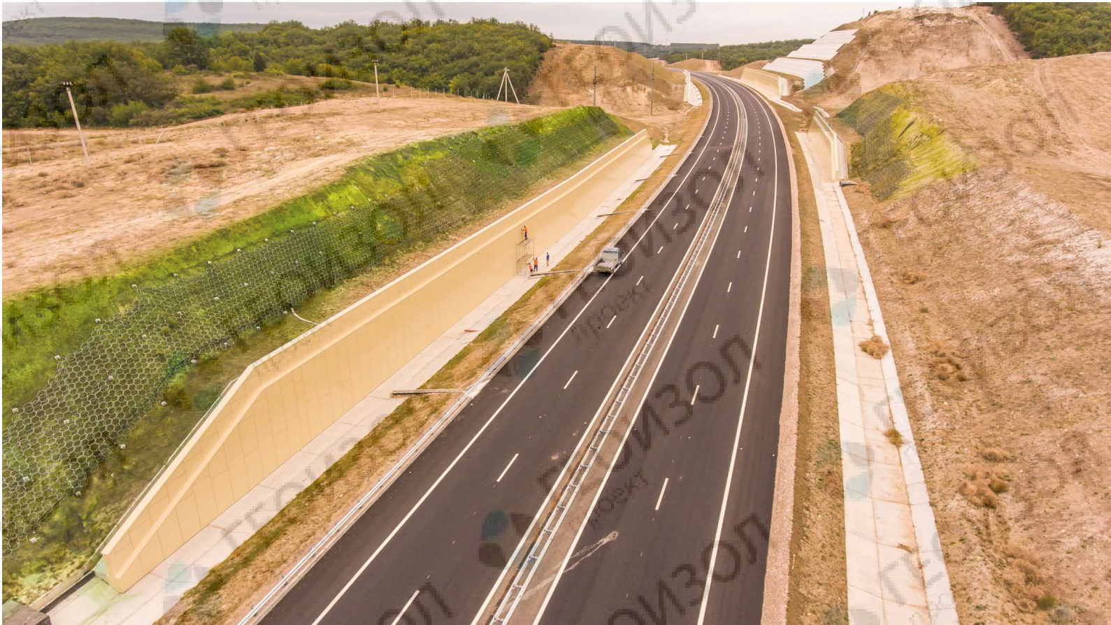
Гидропосев трав на участках с противозрозионной защитой выше подпорных стен. Федеральная автодорога А-291 «Таврида» (7 этап), Крым
