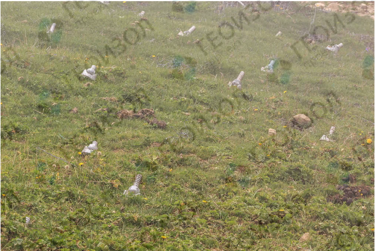
Нагельное крепление склона с восстановленным травяным покровом
