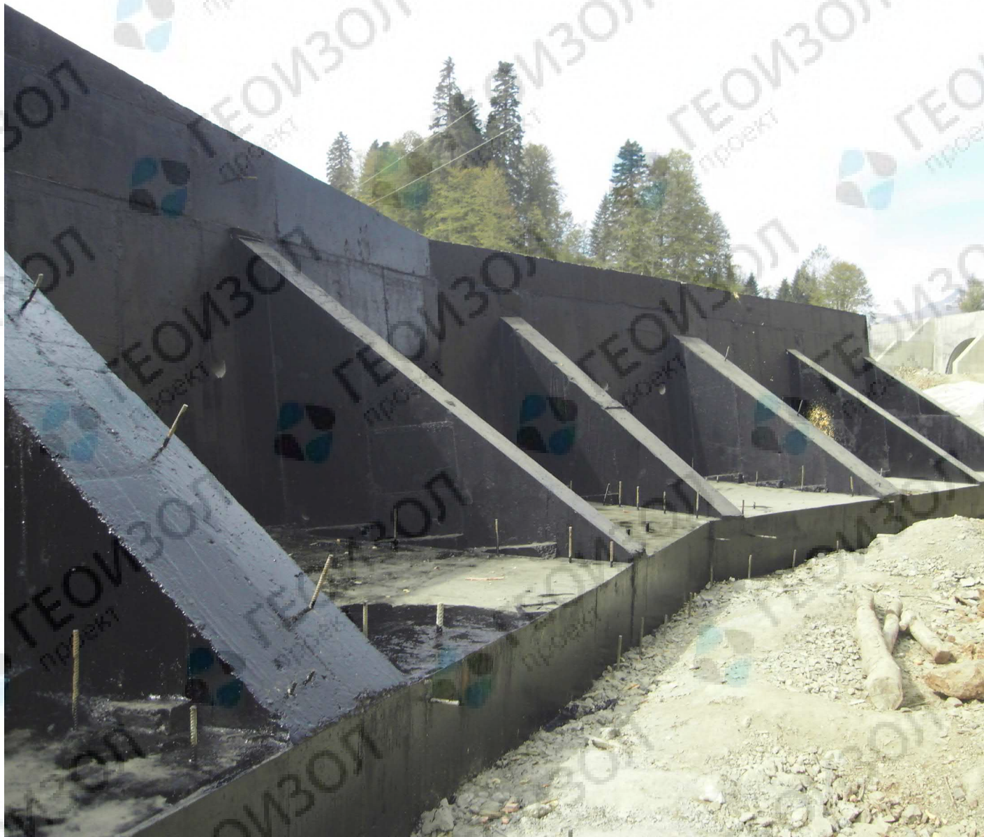
Угловая подпорная стена перед выполнением обратной засыпки. Горнолыжный курорт «Альпика-Сервис», ГТЦ «Газпром», Сочи
