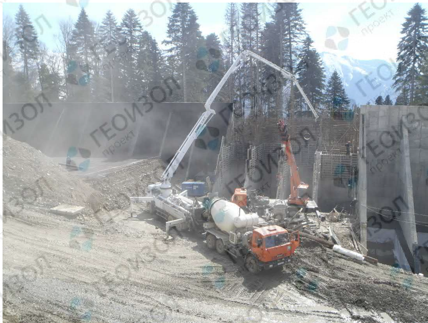
Омоноличивание уголкового подпорной стены, удерживающей склон. Горнолыжный курорт «Альпика-Сервис», ГТЦ «Газпром», Сочи
