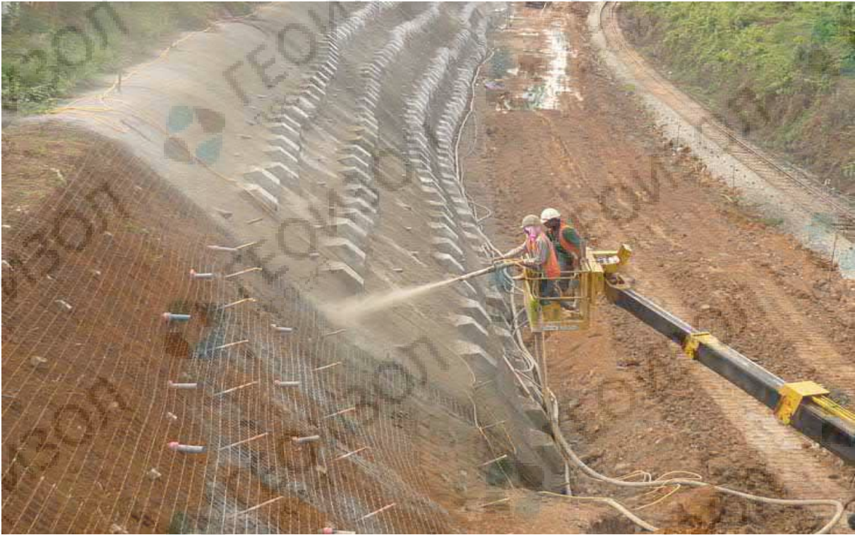
Производство строительно-монтажных работ по торкретированию склона компанией Ranson Civil Technologies Private Ltd. (Индия)
