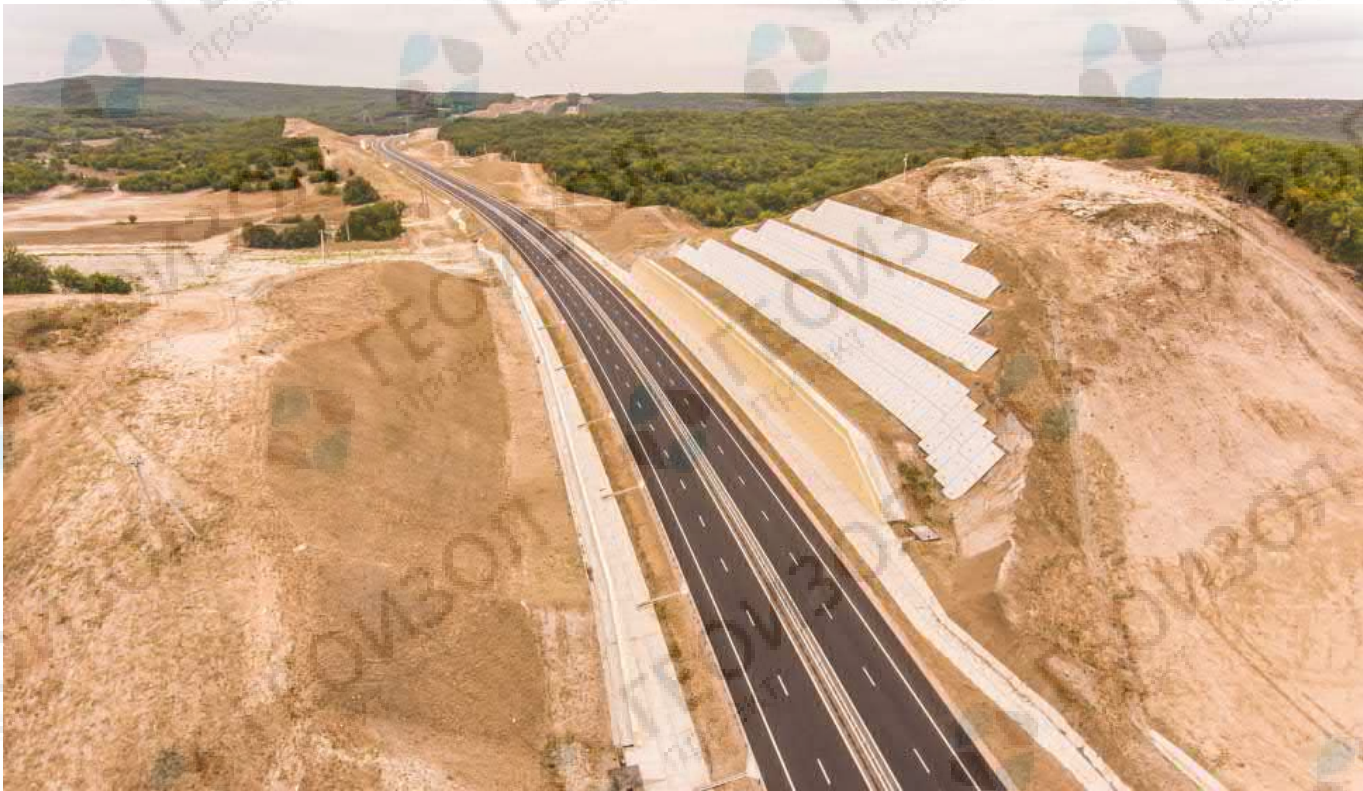
Укрепление оползнеопасного откоса. Федеральная автодорога А-291 «Таврида» (7 этап), Крым
