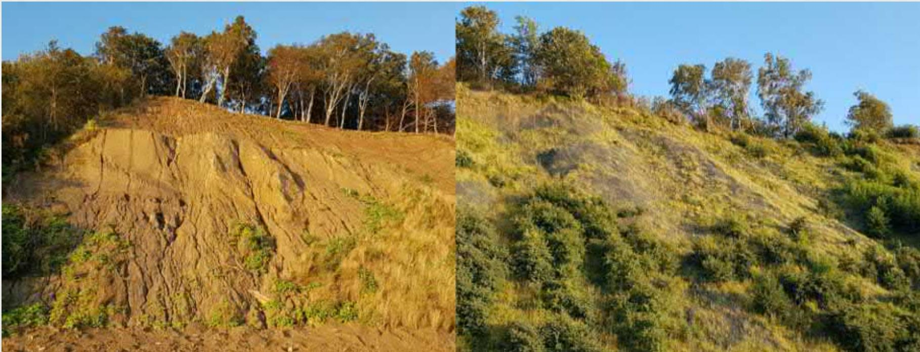
Участок склона до (слева) и после выполнения нагельного крепления и противоэрозионной защиты (справа)
